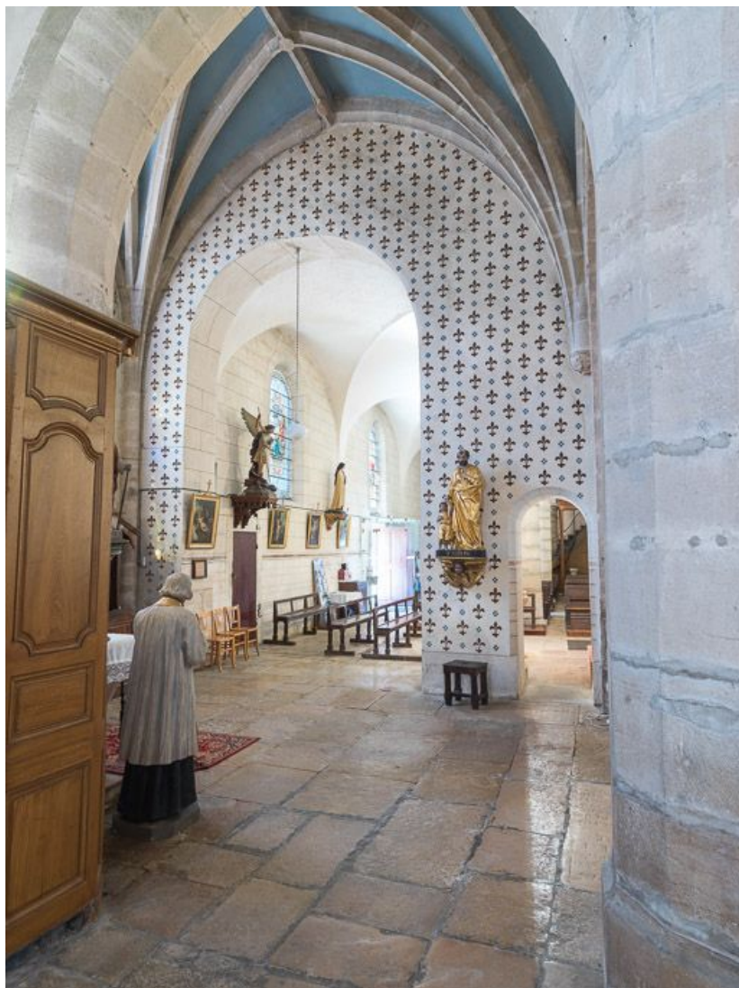
Arcades du mur est de la chapelle sud. 21, Savigny-lès-Beaune place de l' Eglise
