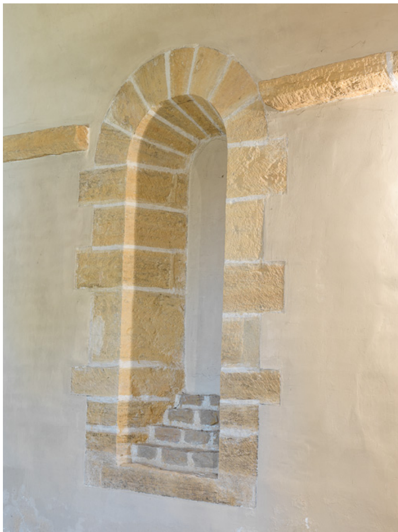
Vue d'une baie murée (mur est du bras nord).
