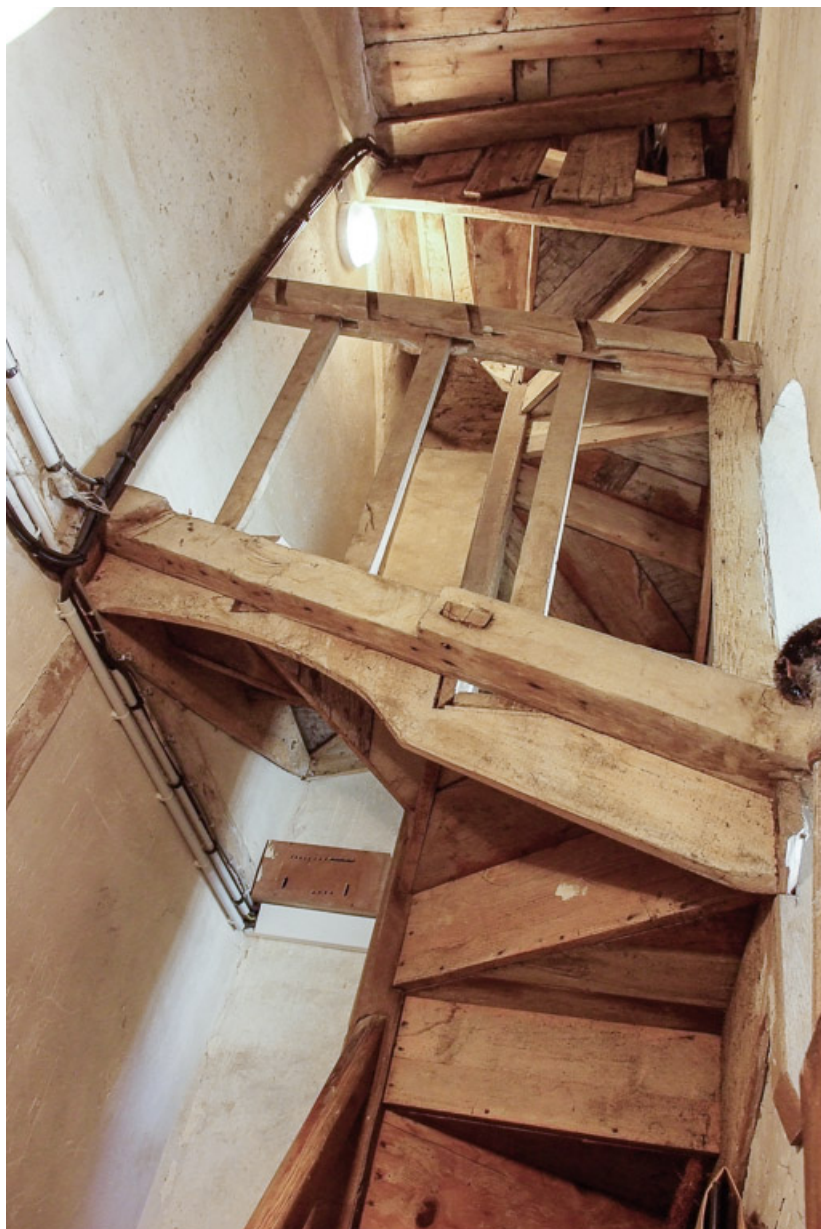
Cage d'escalier menant aux combles.
