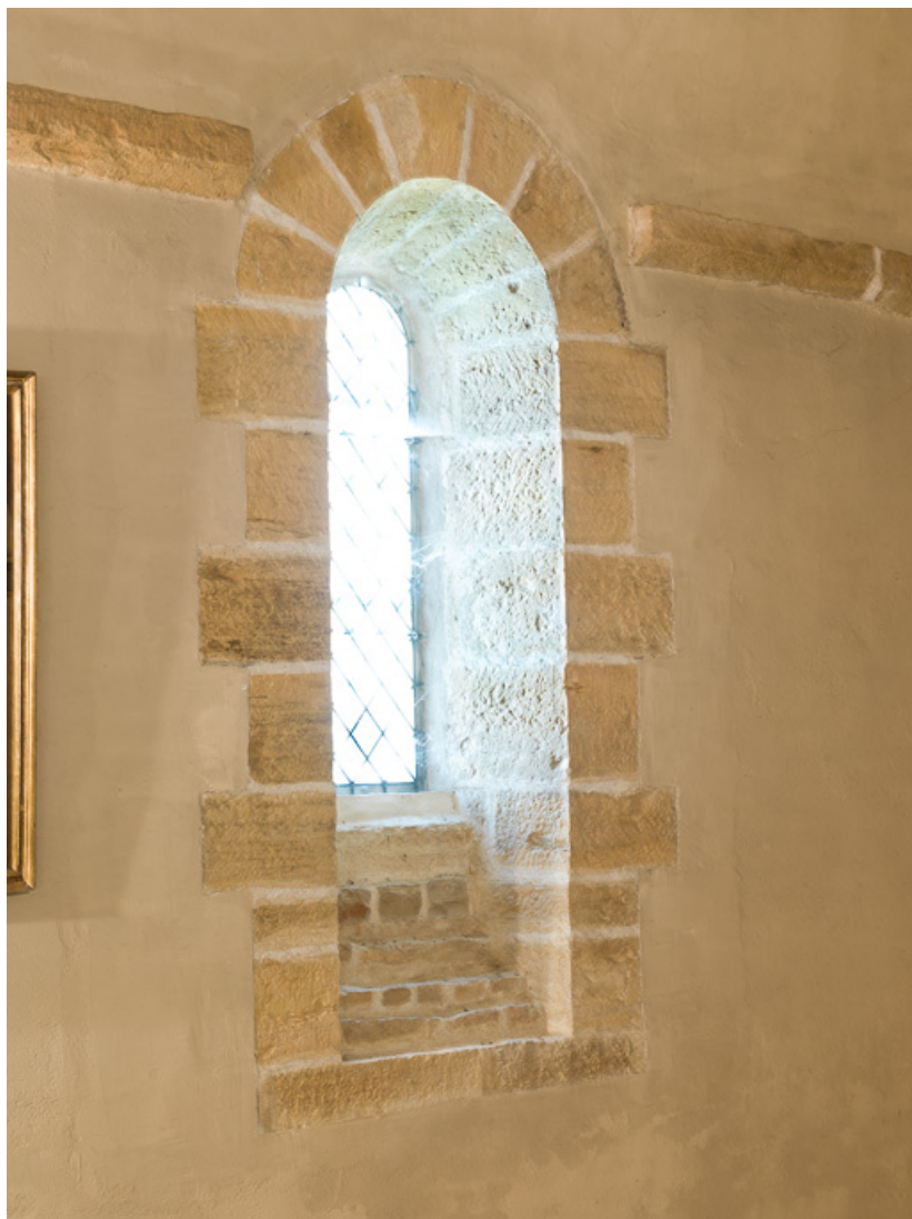
Vue d'une baie (mur ouest du bras nord).
