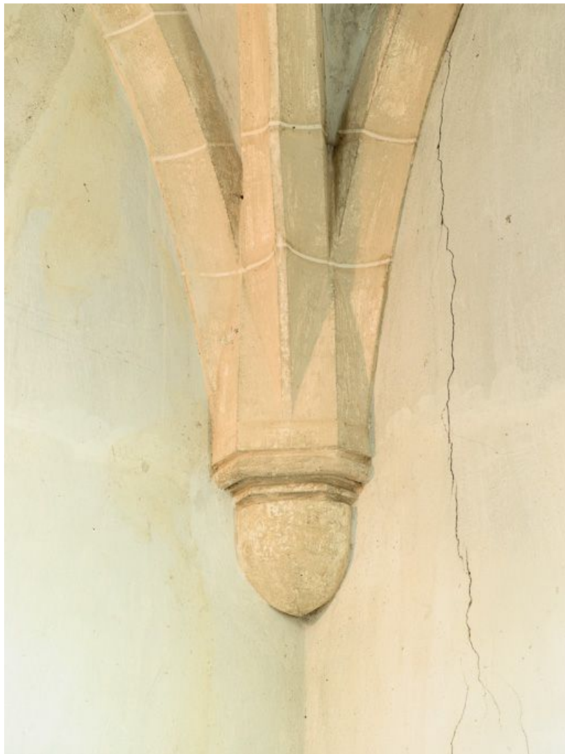
Vue d'un culot et du départ des ogives de la voûte de la sacristie.
