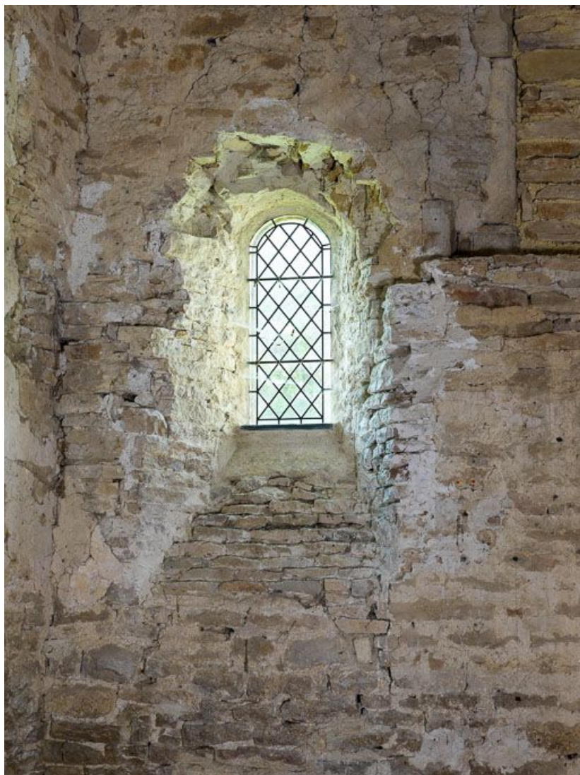
Ancienne chapelle : vue de la baie romane du mur sud.
