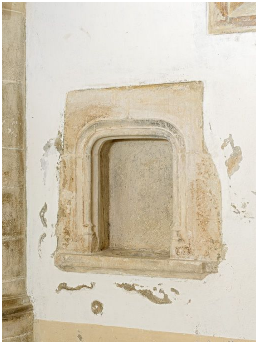
Vue du lavabo situé dans le mur sud de la nef.
