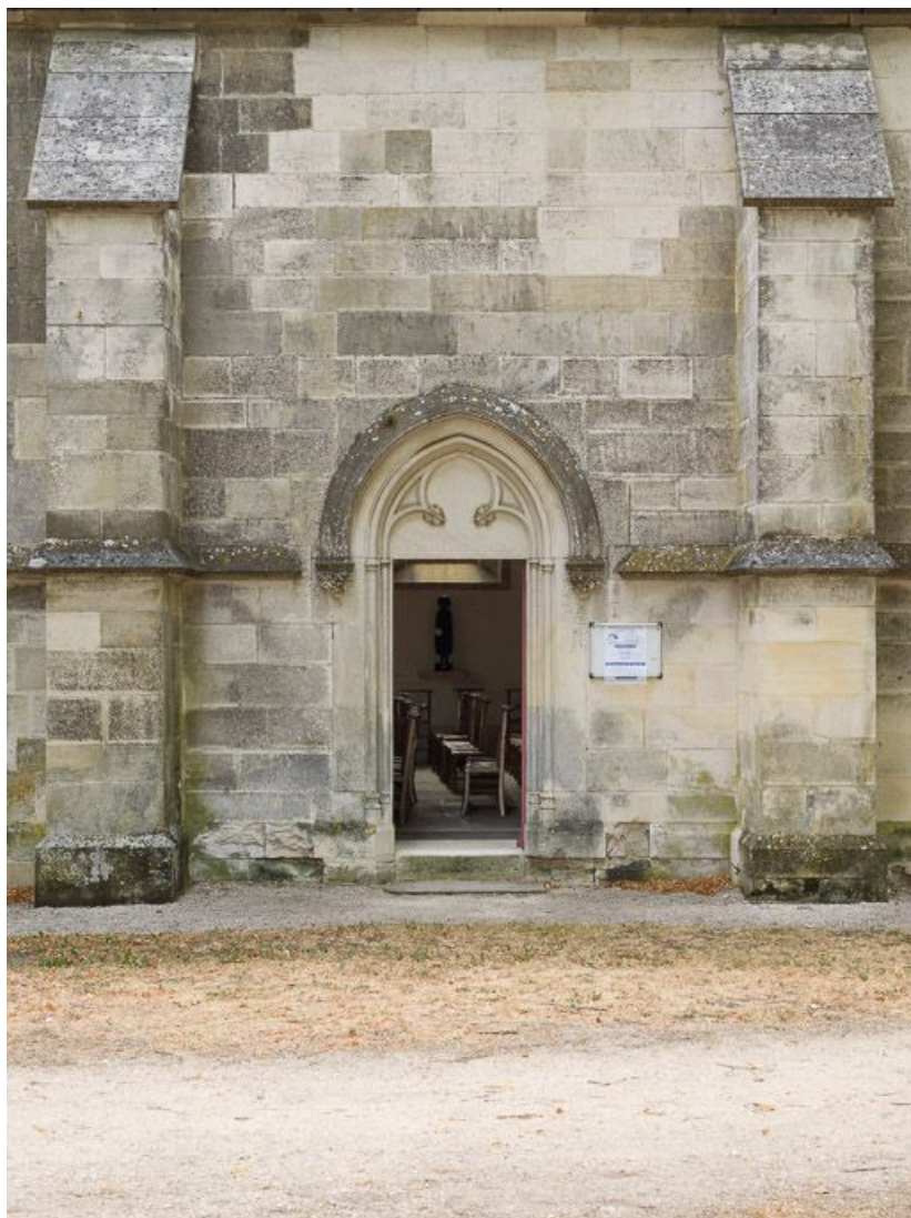
Vue de la porte d'entrée de la chapelle (pignon nord).
