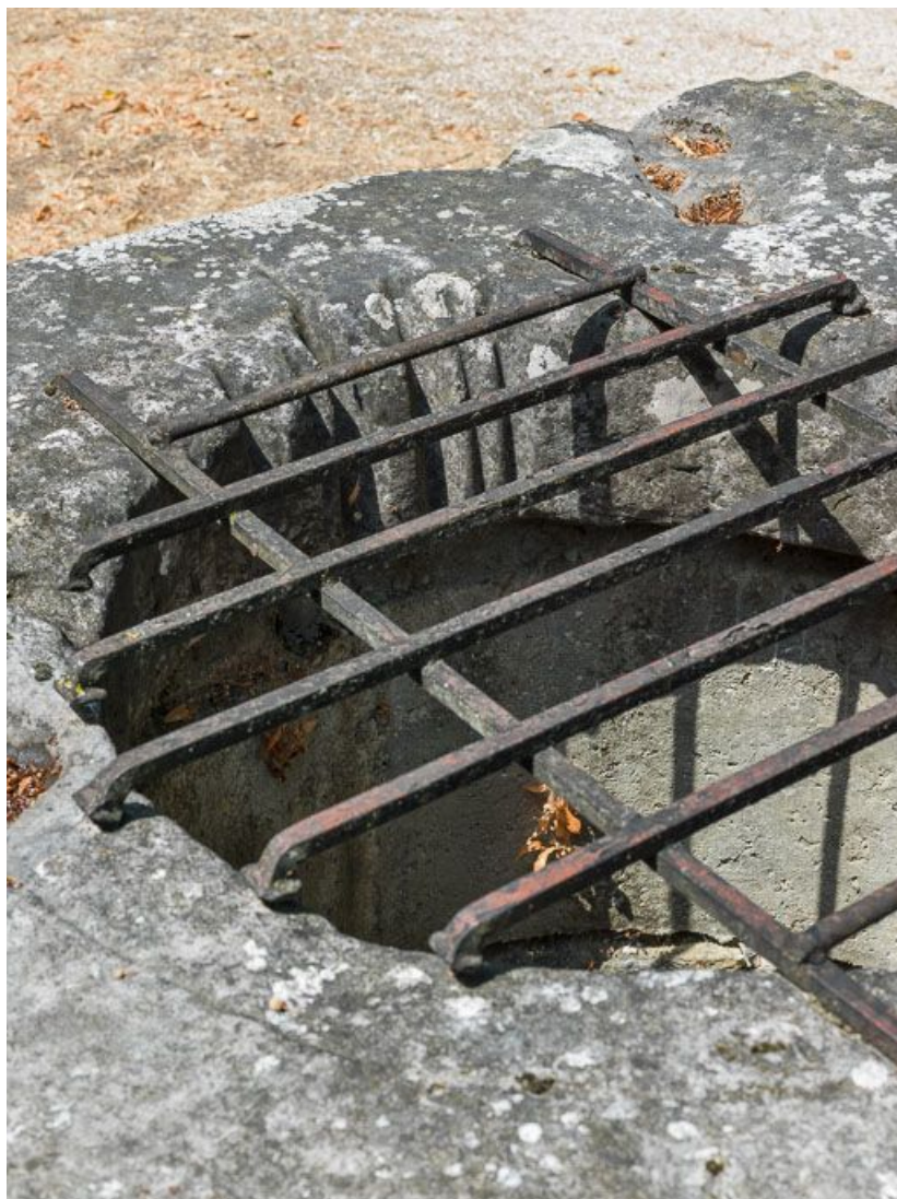
Puits : grille et traces d'usure de cordes.
