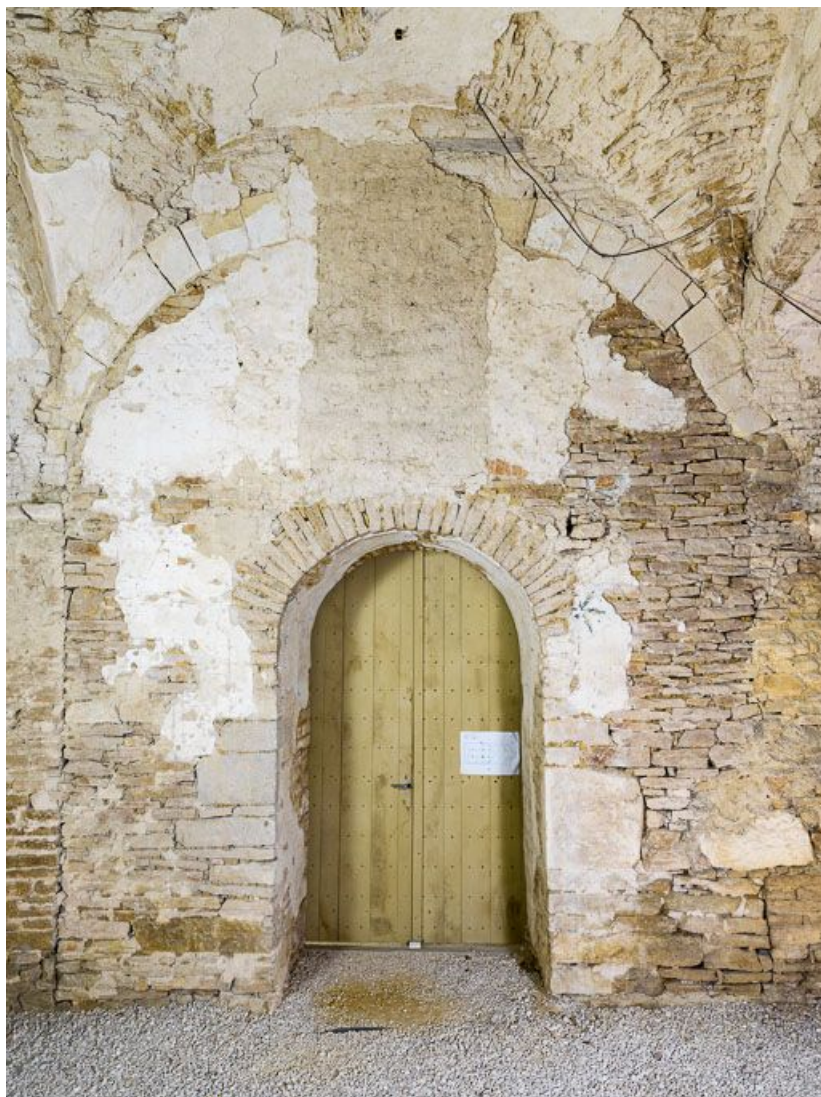
Ancienne chapelle : vue de la porte menant à la chapelle (mur ouest). 21, Ladoix-Serrigny, 1 rue de la Chapelle
