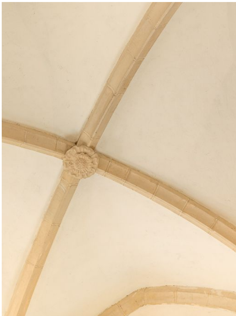
Vue d'une clé de voûte de la nef (travée ouest).
