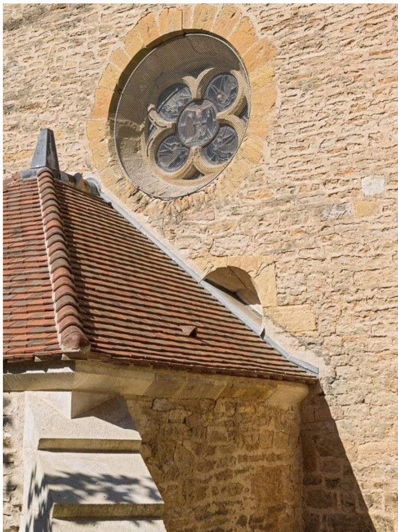
Détail de l'oculus et de la baie murée du chœur.
