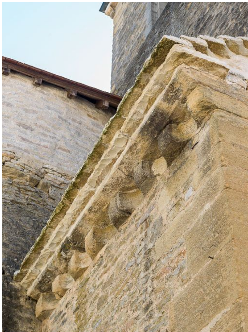
Élévation nord-est, détail des corniches.
