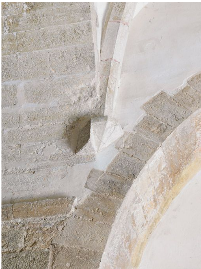
Culot de la voûte de la travée sous clocher. 21, Pernand-Vergelesses rue Jacques-Copeau
