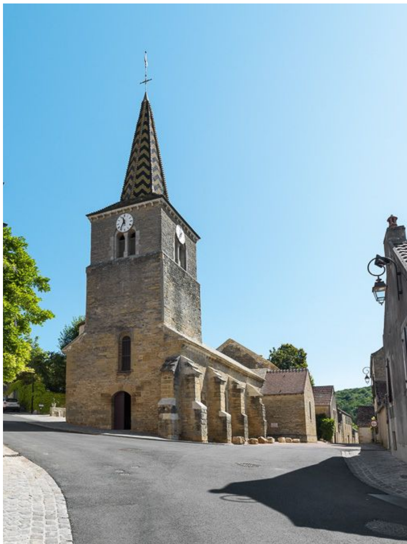
Vue d'ensemble, façade et élévation sud-ouest.
