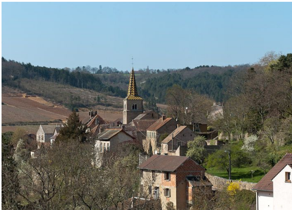
Vue générale de l'église et du village de Pernand-Vergelesses.
