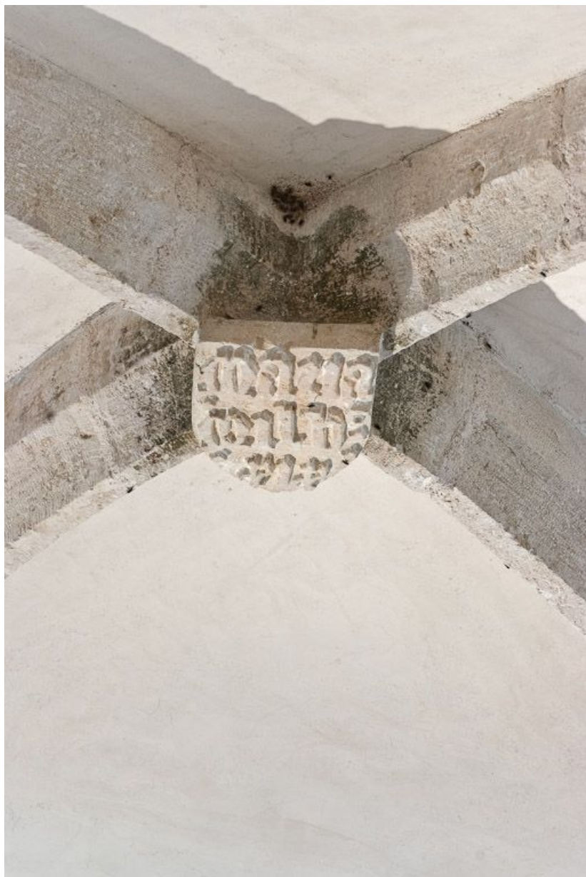
Clef de voûte de la deuxième travée de la nef. 21, Volnay Eglise
