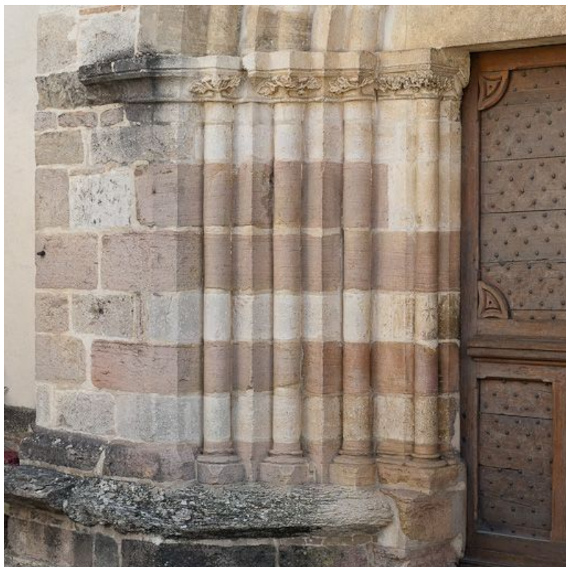
Portail : colonnettes gauches de l'ébrasement. 21, Volnay Eglise
