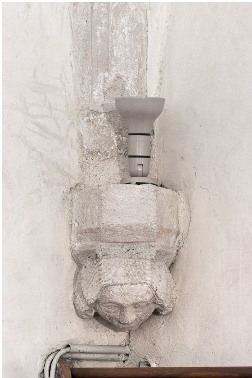
Culot antérieur gauche de la première travée de la nef. 21, Volnay Eglise
