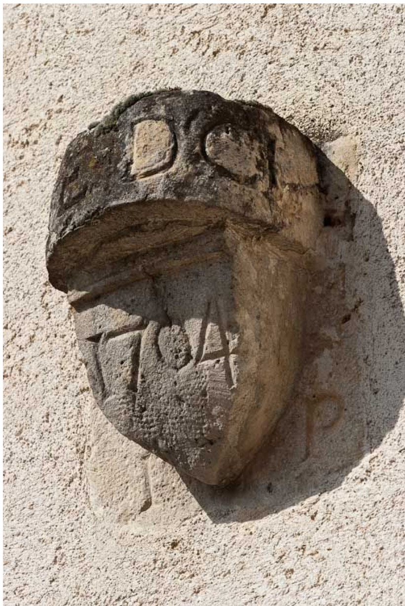
Console extérieure sur le mur de la sacristie. 21, Volnay Eglise
