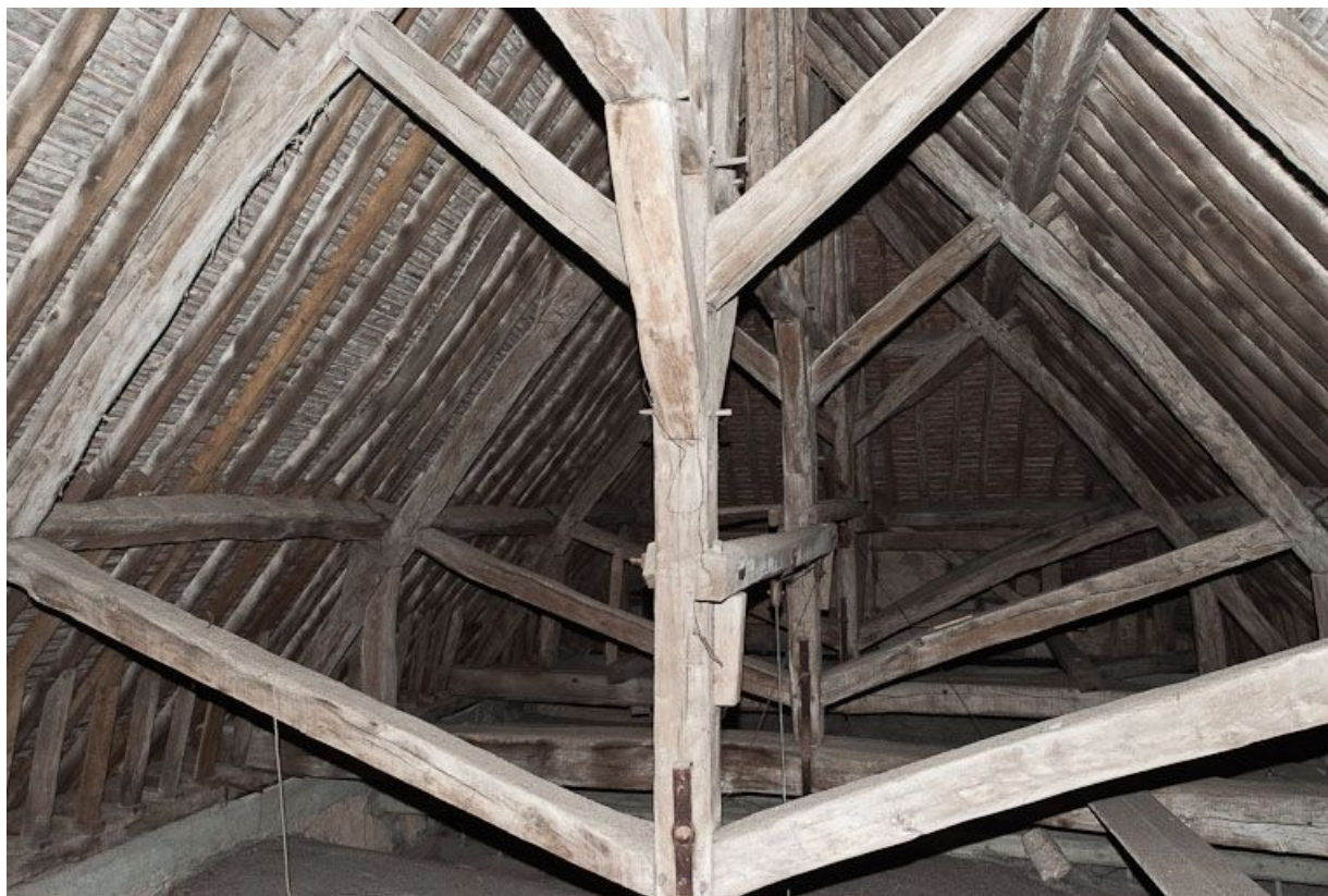
Partie du comble vers la façade.
