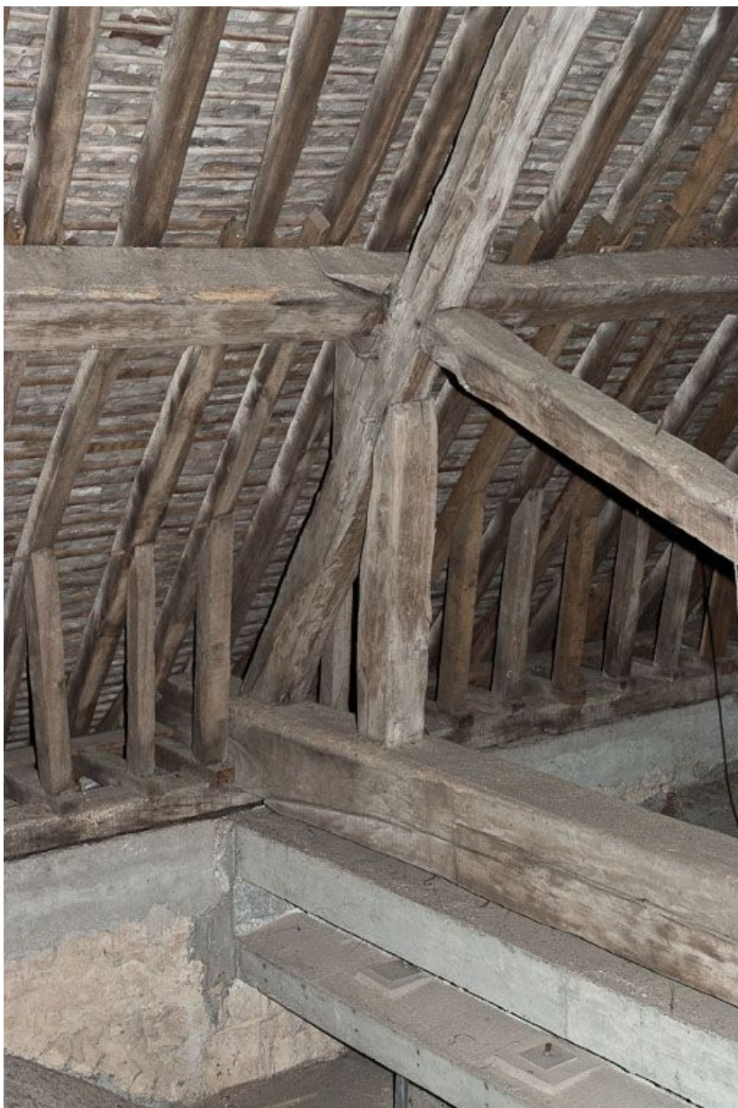
Partie du comble vers la façade : détail d'une ferme et de la sablière. 21, Pommard Métairie
