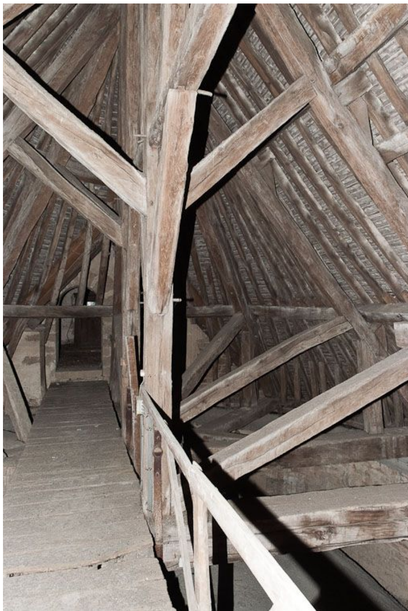
Charpente du chœur. 21, Pommard Métairie
