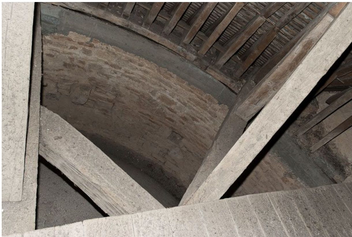
Comble de l'abside, partie gauche.
