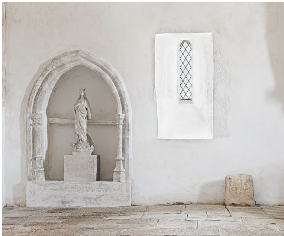
Niche et fenêtre de la deuxième travée du bas-côté droit.
