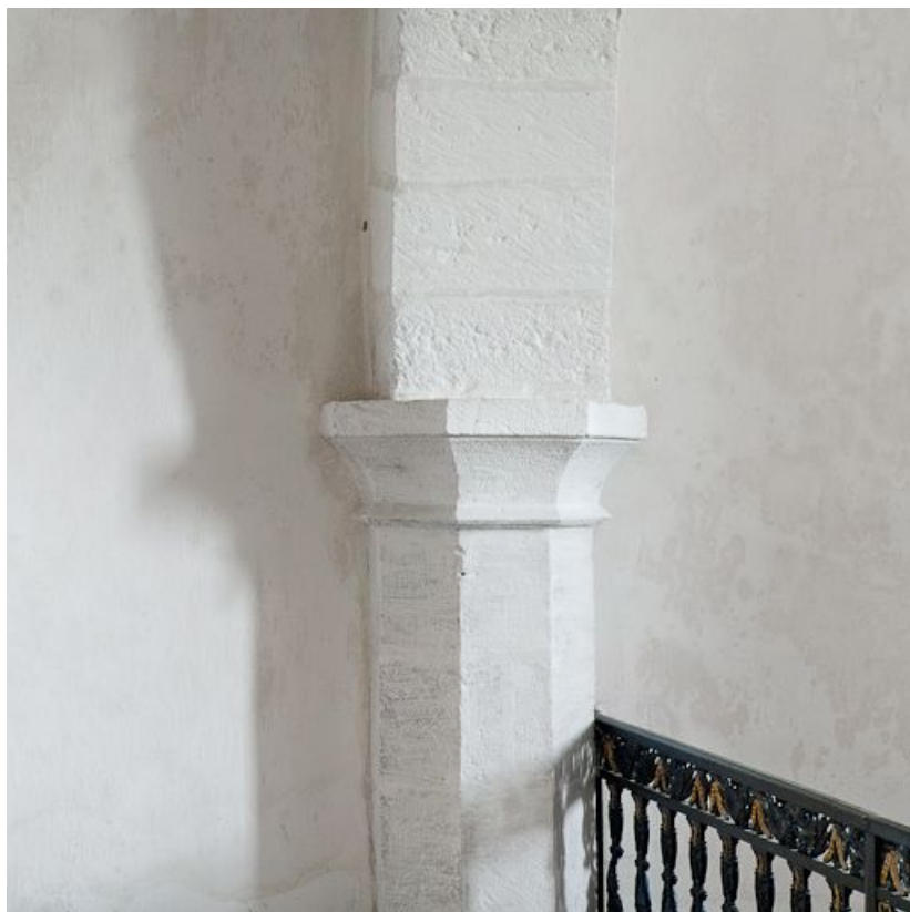
Chapelle des fonts baptismaux, détail du pilier droit.
