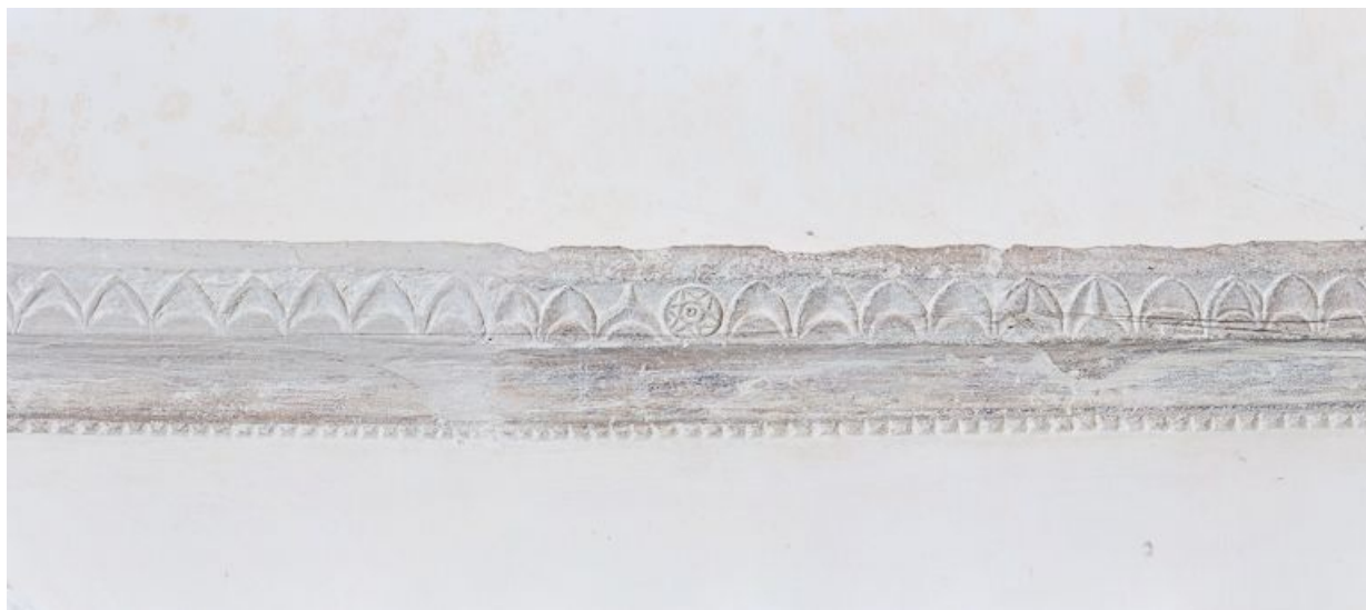
Détail corniche gauche de la travée du choeur.
