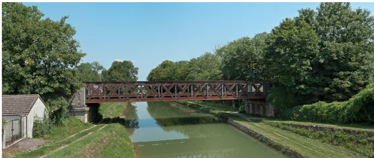
Vue du pont.
