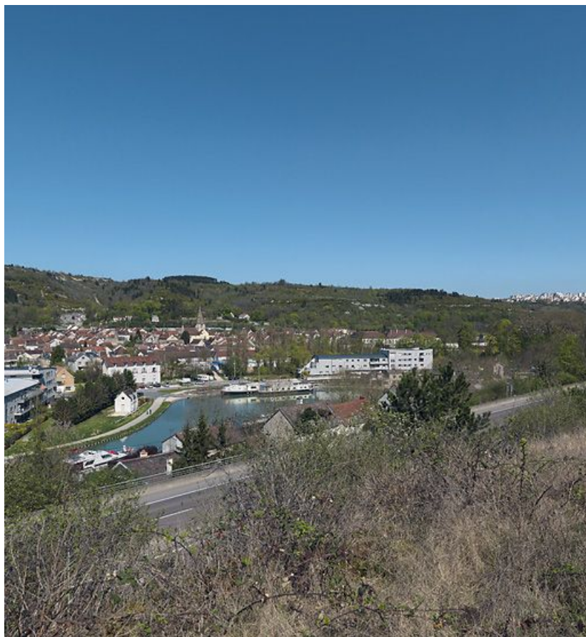
Vue d'ensemble du port de Plombières-lès-Dijon.
