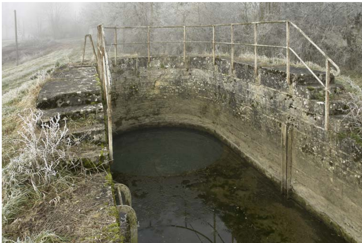
Entrée en siphon dans l'aqueduc parallèle au bief n° 3 et n° 2, versant Saône.
