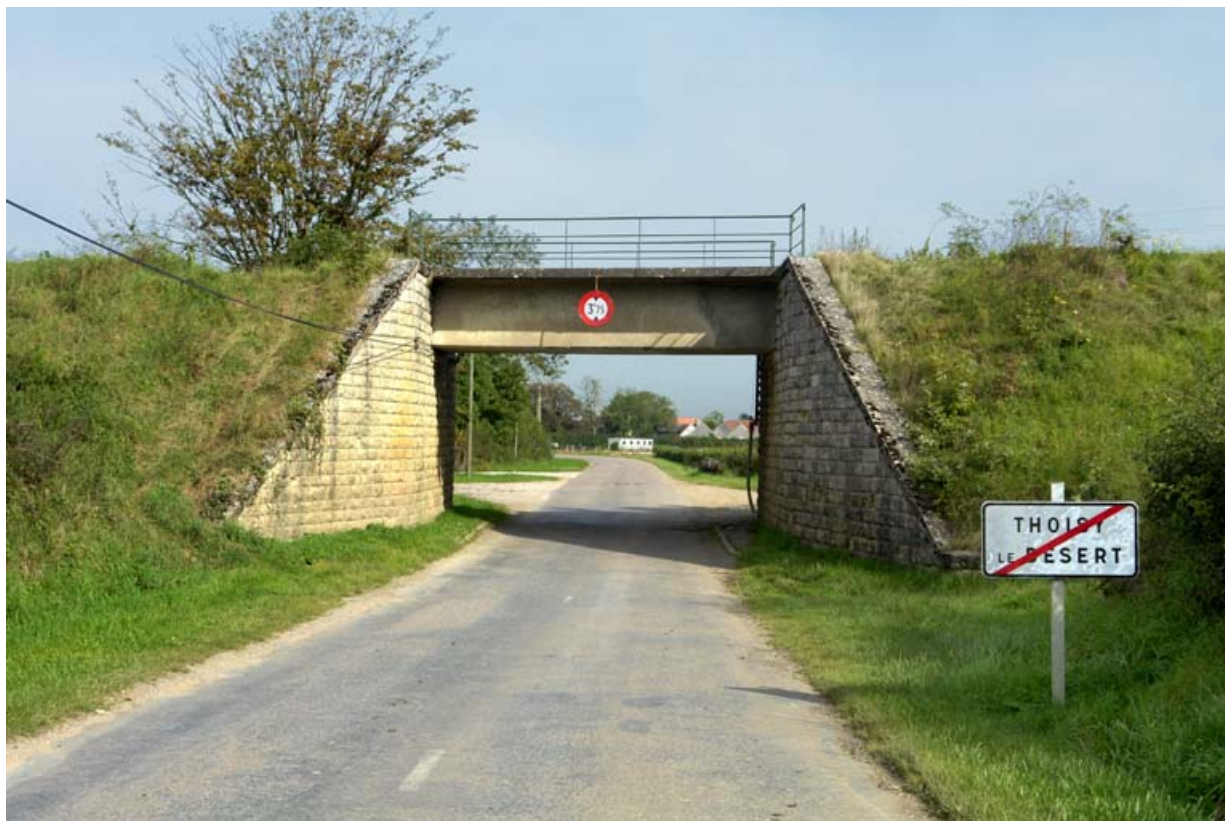
Rigole d'alimentation de Cercey ; passage supérieur, vue de la route D.108.
