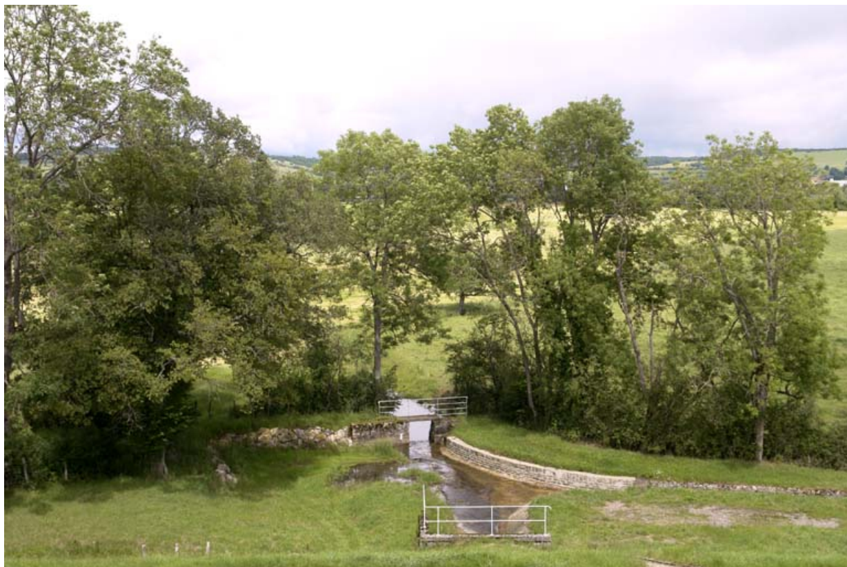
Décharge de fond au centre de la digue principale ; rigole. Jonction des eaux issues de cette décharge de fond et de celles du déversoir.
