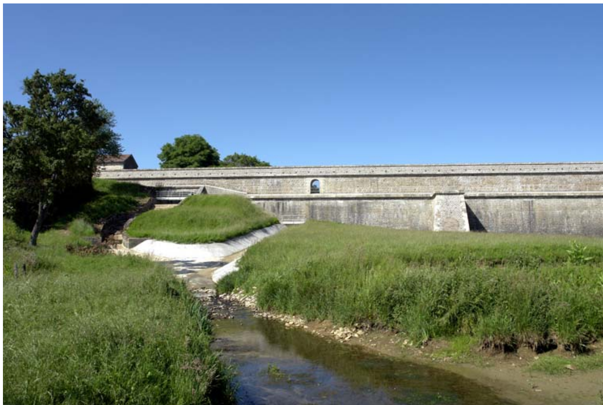
Face avant du barrage, vue d'ensemble avec au premier plan la rigole de décharge.
