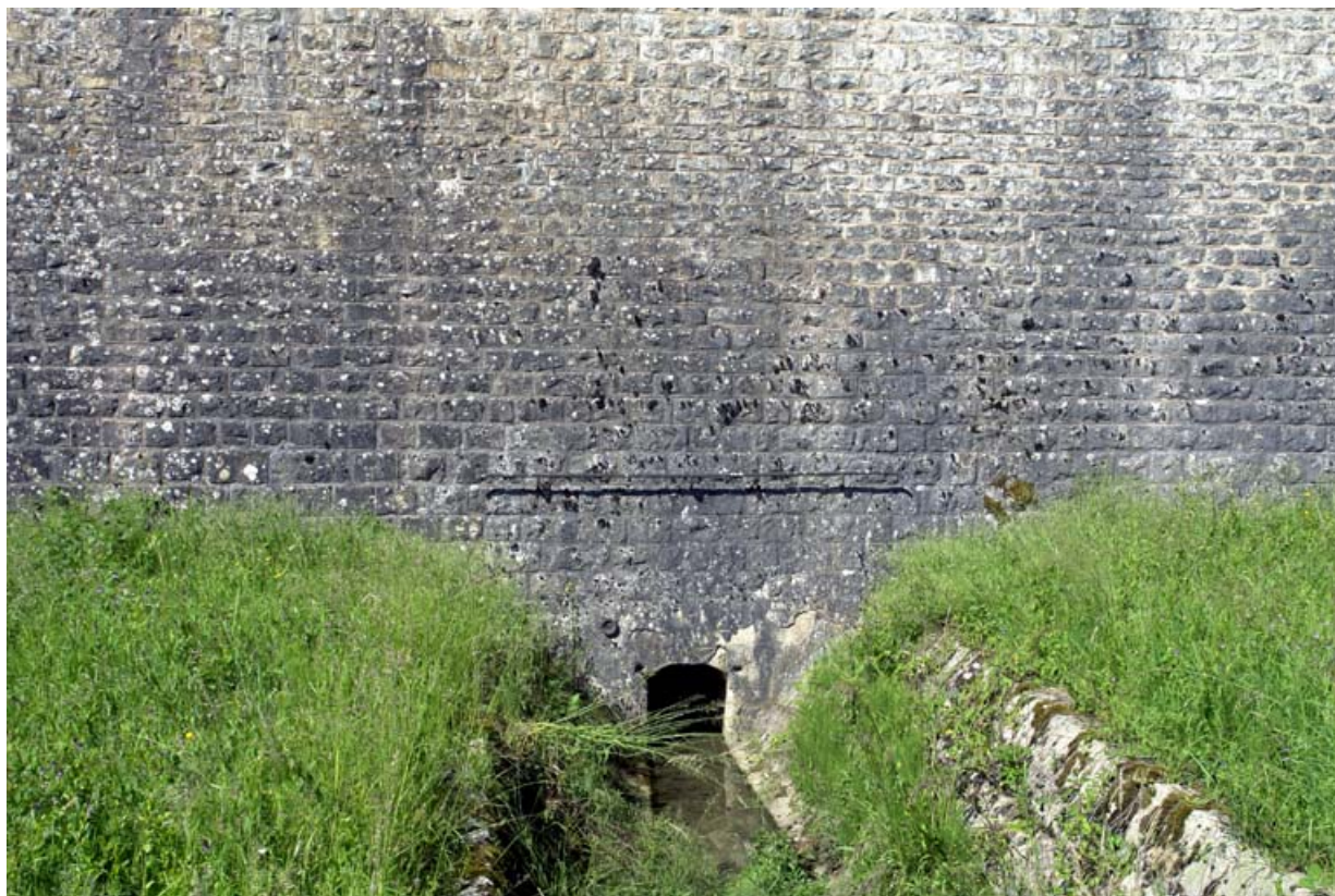
Face avant du barrage, sortie de la vanne de fond.
