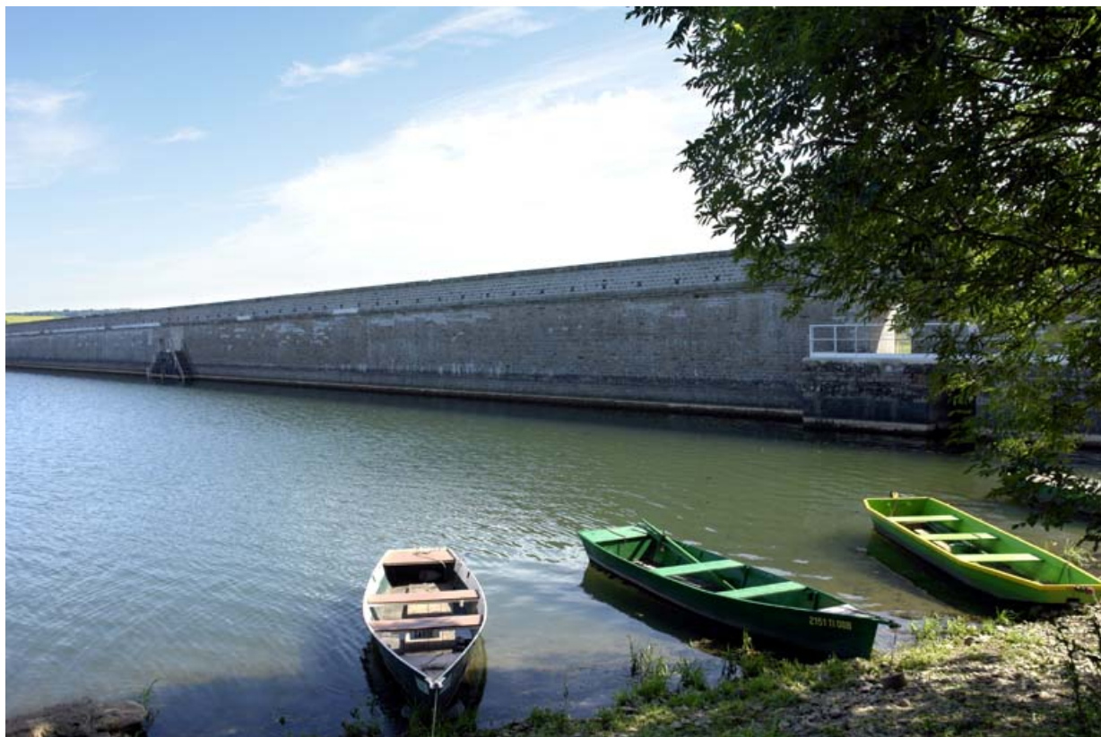
Vue d'ensemble du barrage, face réservoir.
