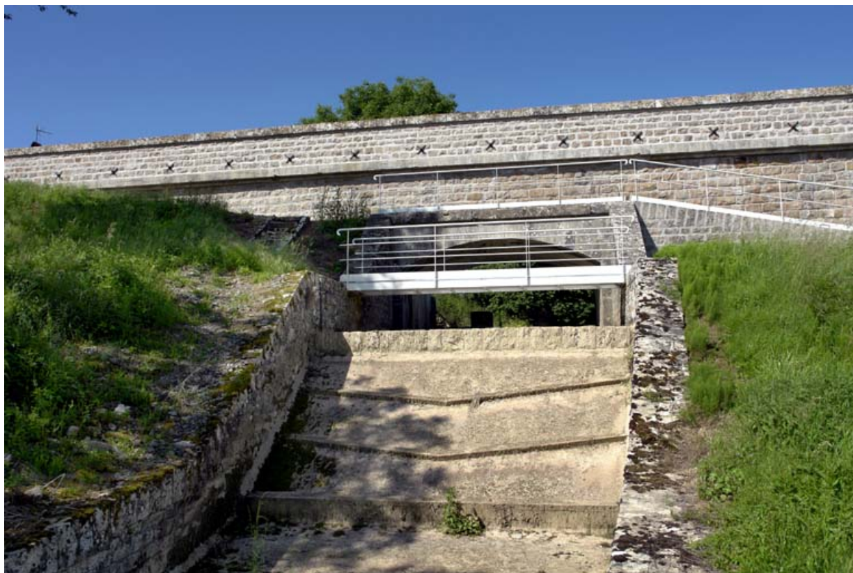
Déversoir de superficie du réservoir, prolongé par une chute d'eau en trois paliers et surmonté d'une passerelle. 21, Rouvres-sous-Meilly, lieudit : le Tillot
