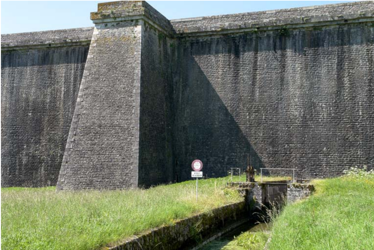
Face avant du barrage avec un contrefort et la rigole d'alimentation du canal.
