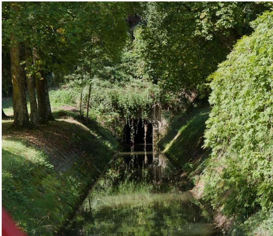
Vue du départ de la rigole d'alimentation en aval du barrage de Pont.
