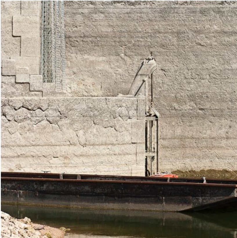
Détail de la vanne de la tour de prise d'eau.
