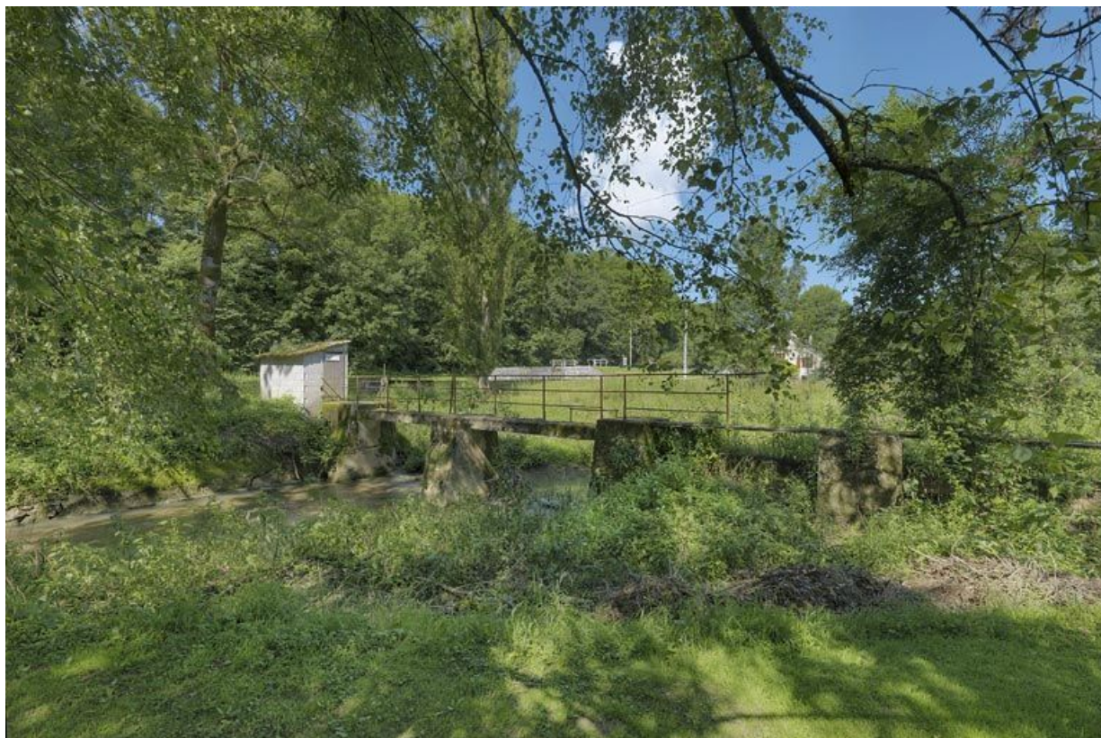
Une passerelle enjambant la Vandenesse, dans le prolongement du déversoir de superficie, dans le hameau lié à la cimenterie de Crugey.
