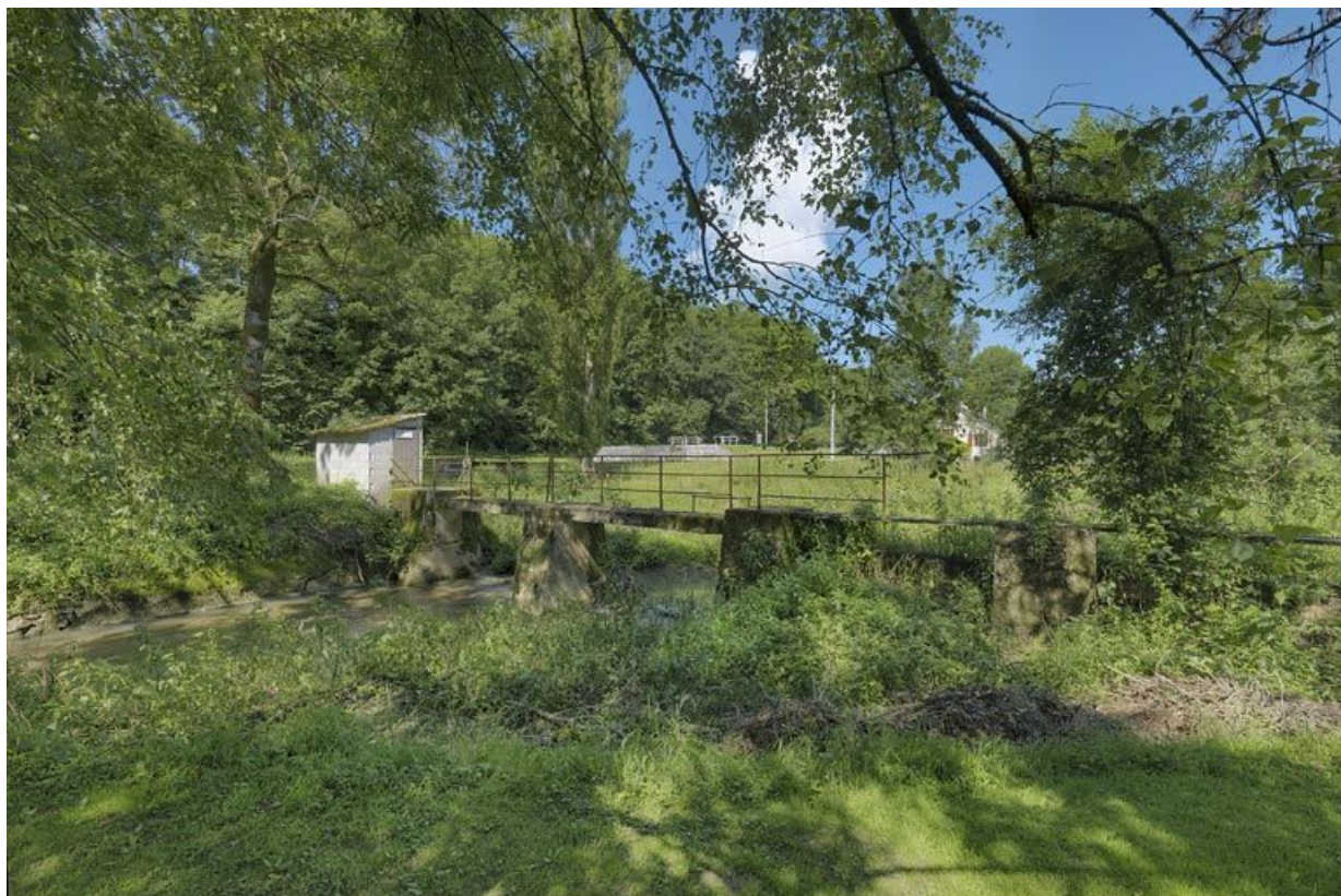
Une passerelle enjambant la Vandenesse, dans le prolongement du déversoir de superficie, dans le hameau lié à la cimenterie de Crugey.
