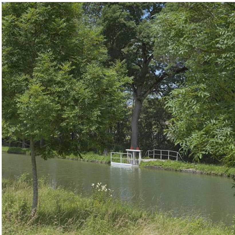
Vannes et garde-corps du déversoir vus de la rive droite.
