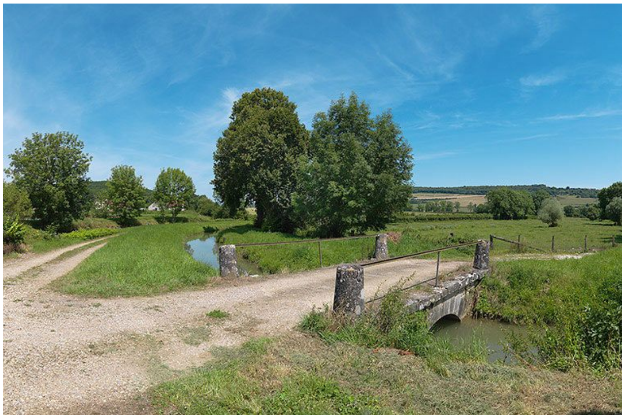
Pont sur la rigole en amont de son arrivée vers le canal.
