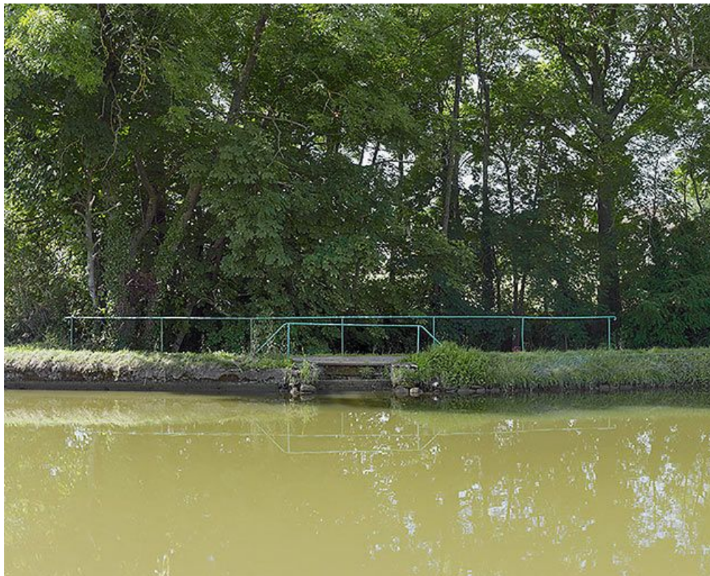
Vue du garde-corps de l'entrée de la Vandenesse sous le canal rive droite.
