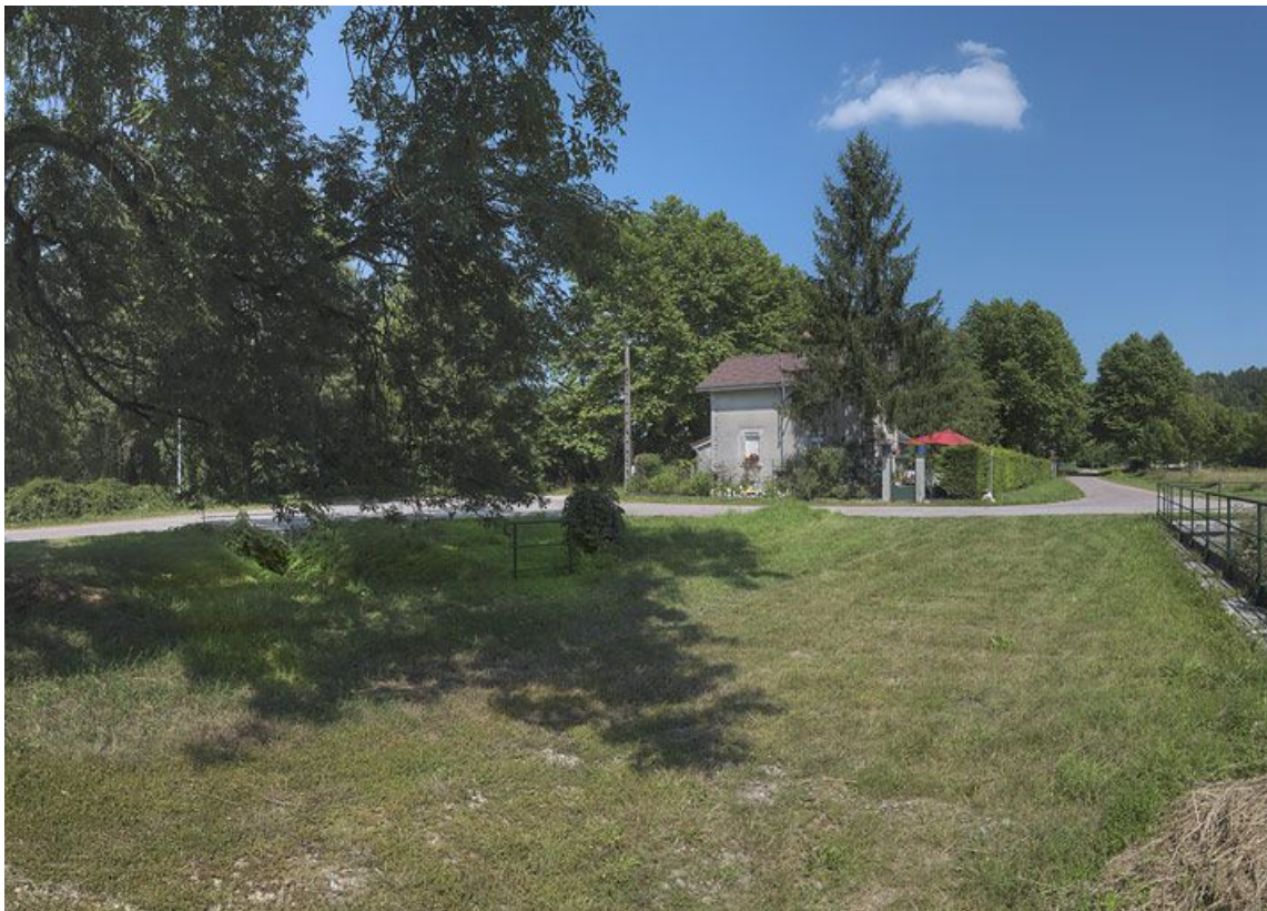
L'ancienne maison de garde-barrière dans son site. On distingue à droite le garde-corps de la rigole d'alimentation. 21, Gisse-sur-Ouche rue de Saint-Thaux, lieudit : bief 33 du versant Saône
