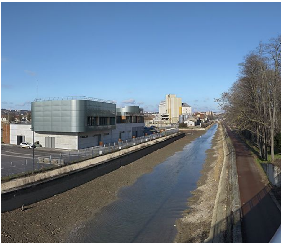
Nouveau poste d'aiguillage informatisé de la SNCF, sur la rive droite du canal à Dijon (à gauche de l'image). Le bief est vide pour permettre les travaux de réfection du pont sur l'écluse 55.
