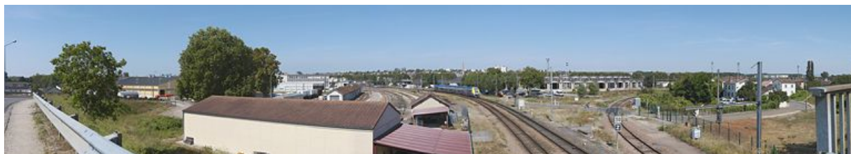
Vue d'ensemble du site SNCF et de la rotonde ferroviaire à Migennes. On aperçoit la flèche de l'église du Christ-Roi.
