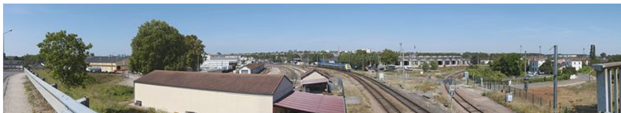
Vue d'ensemble du site SNCF et de la rotonde ferroviaire à Migennes. On aperçoit la flèche de l'église du Christ-Roi.
