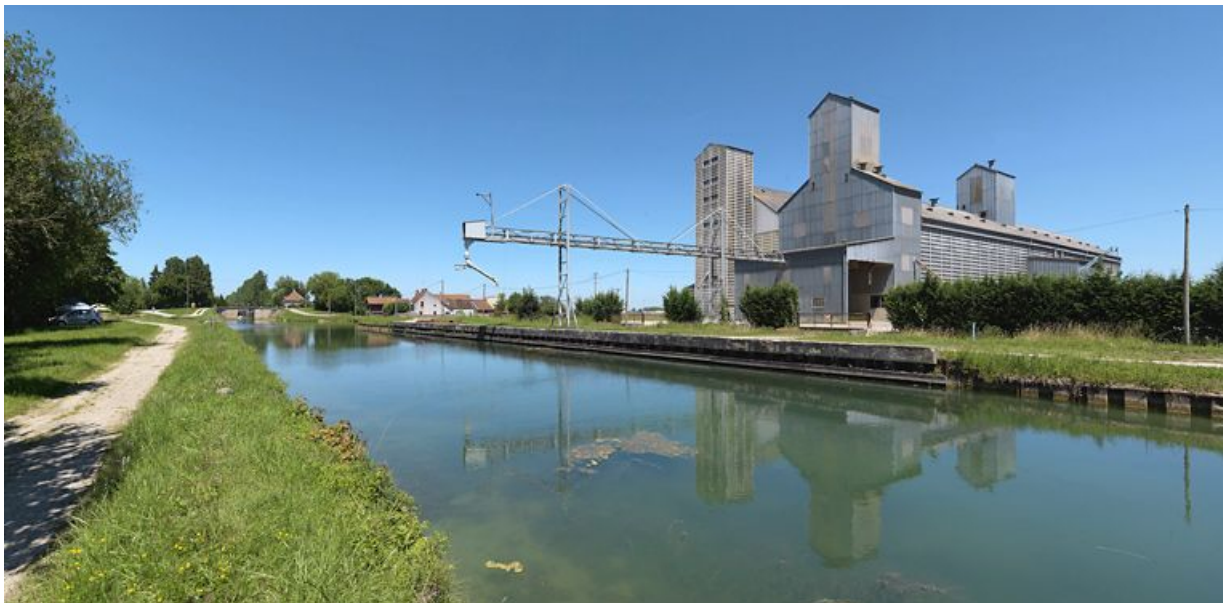
Silos à Longecourt-en-Plaine.
