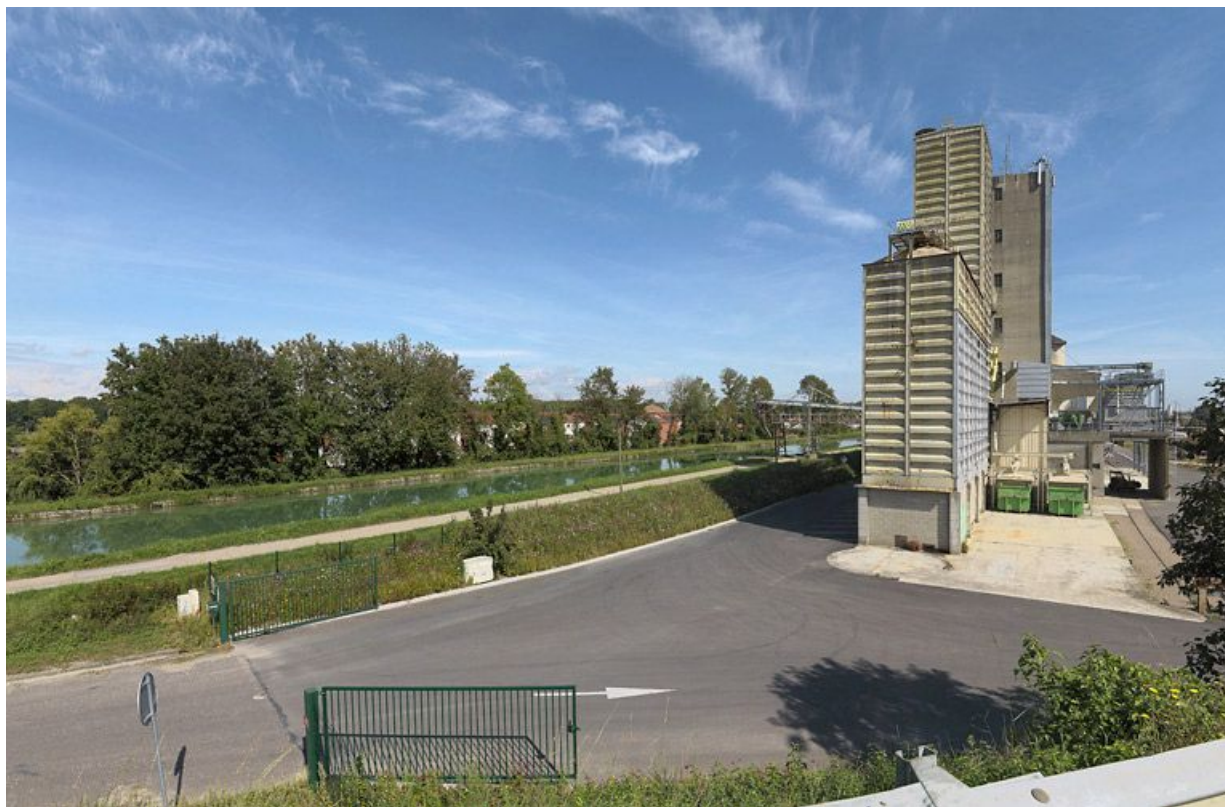
Les silos en bordure du canal après Eson.
