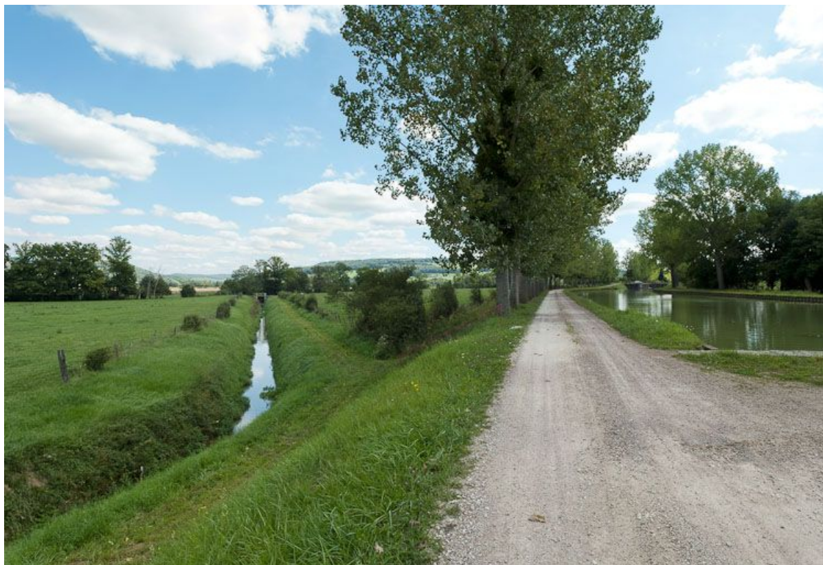
Vue du canal et d'une rigole de déversoir à Mussy-la-Fosse.
