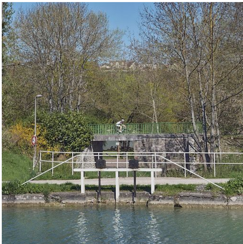
Les vannes du déversoir. Au fond, l'ancien pont de la ligne de chemin de fer Dijon-Epinac. 21, Dijon, lieudit : bief 52 du versant Saône
