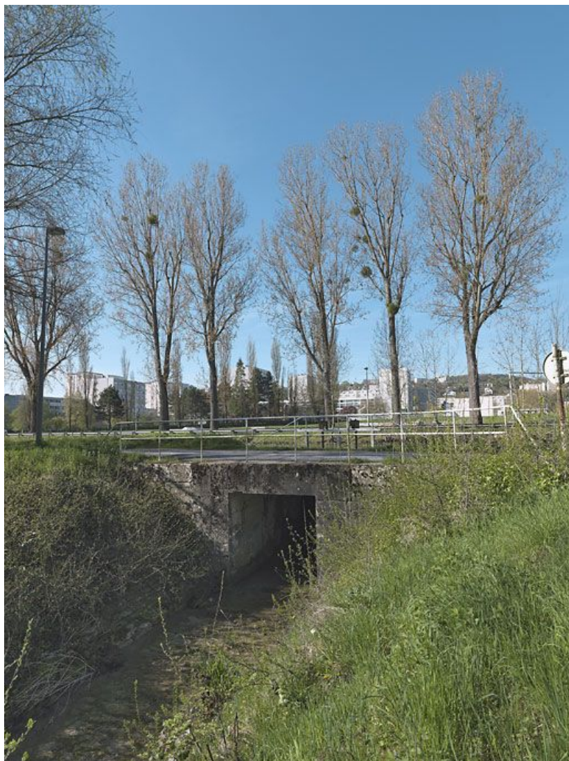
Déversoir du canal : en arrière-plan, le canal, puis les vannes du déversoir, le pont sur chemin de halage enjambant la rigole d'amenée de l'eau.
