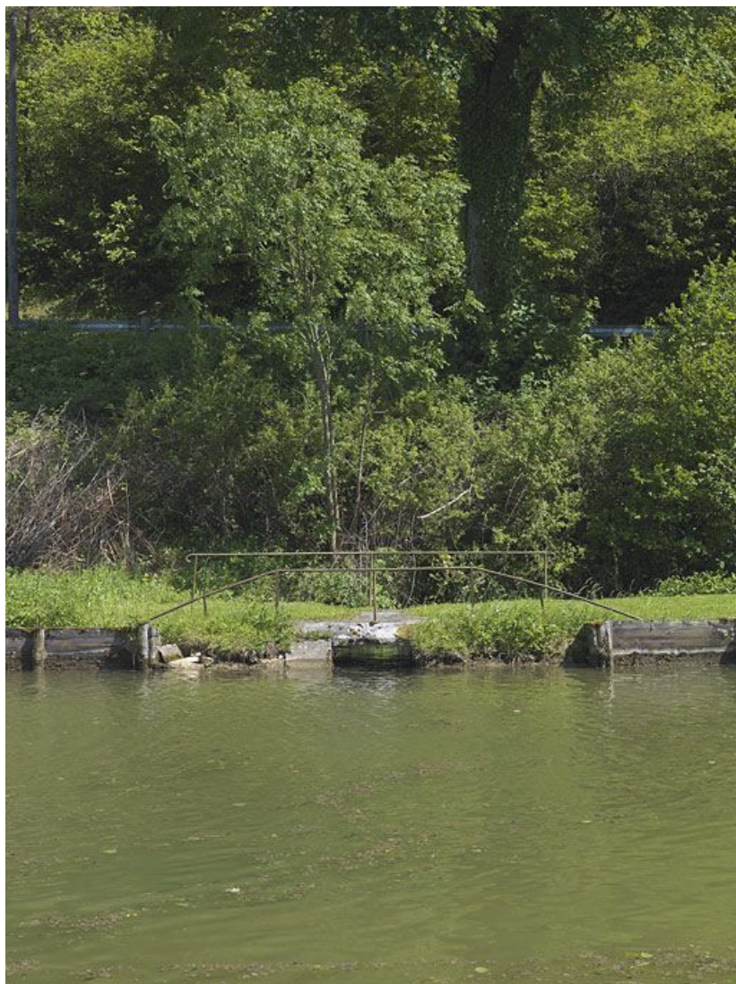
Rive droite : arrivée de la rigole d'alimentation plus en aval dans le bief.
