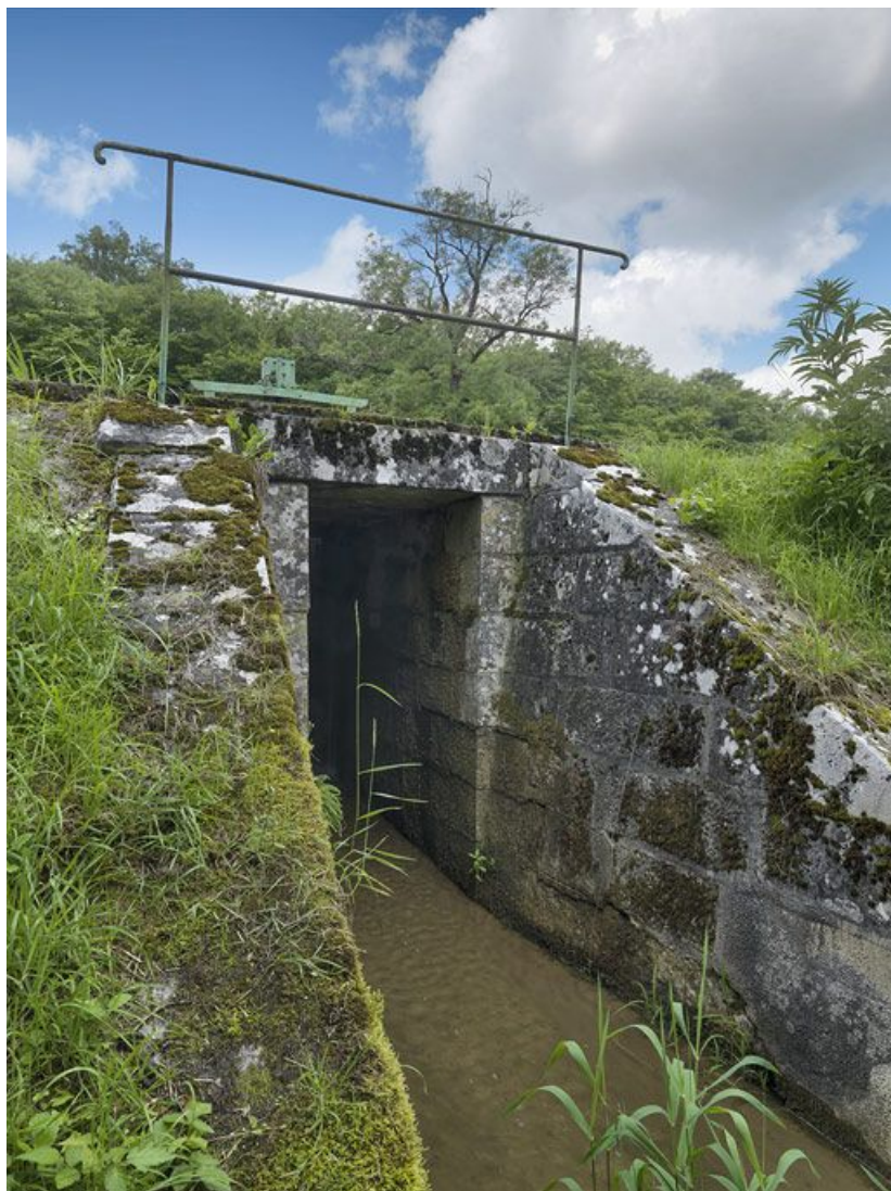
Déversoir rive gauche : sortie du déversoir.
