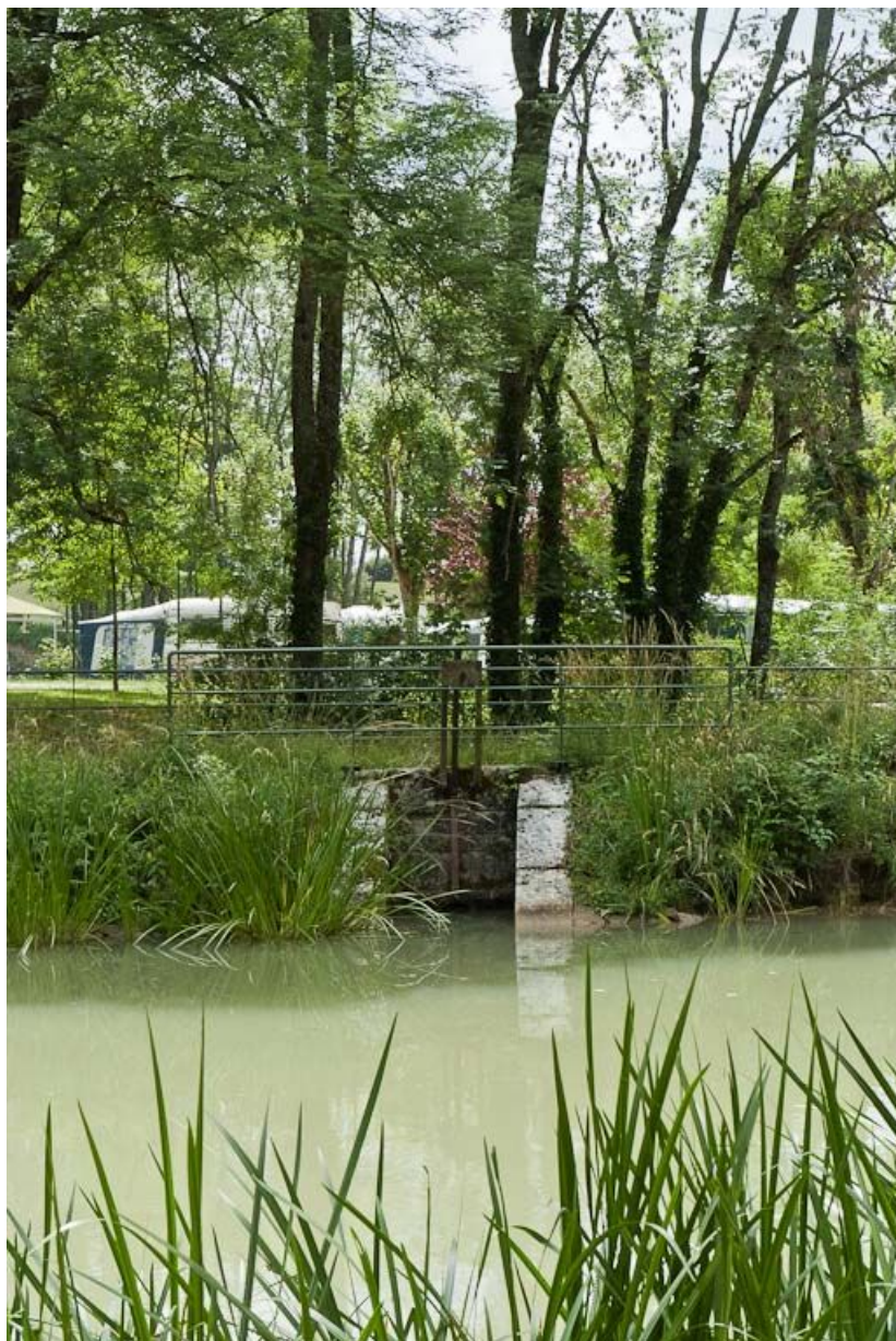
Vue du déversoir de fond sur la rive gauche.
