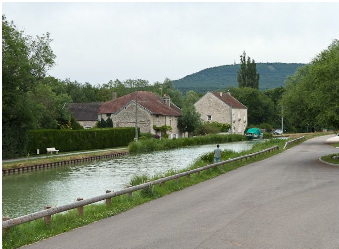
Vue des anciens moulins situés sur la rive gauche du canal.
