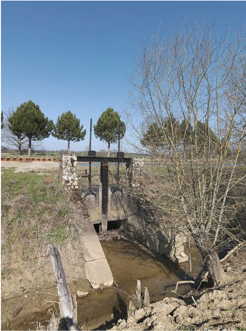
L'aqueduc-déversoir avec ses vannes passant sous le canal en amont du site d'écluse 16. 21, Charigny, lieudit : bief 16 du versant Yonne
