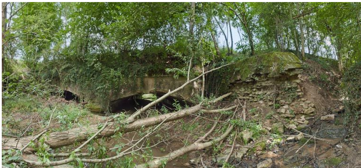
Vue des deux arches de l'aqueduc.
