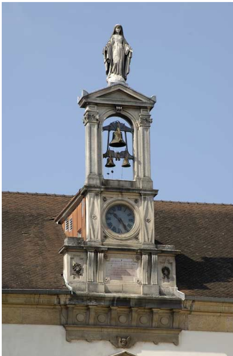
Campanile sur le corps de bâtiment central. 21, Auxonne rue Colonel-Denfert
