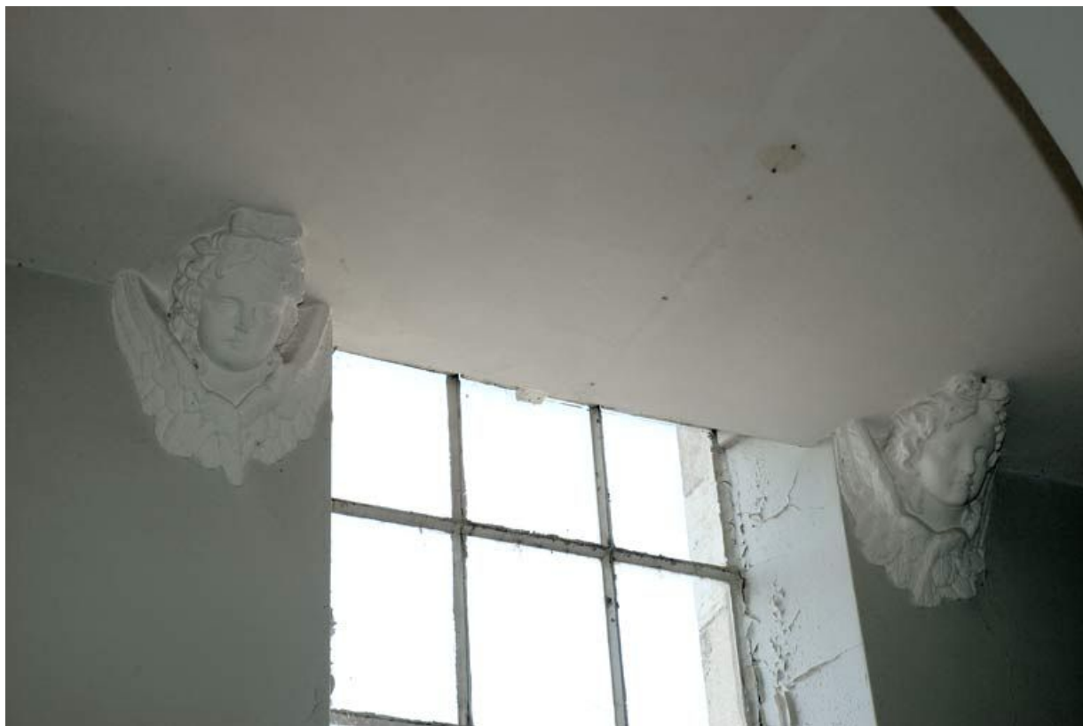
Consoles encadrant la fenêtre du palier de l'escalier de la galerie.
