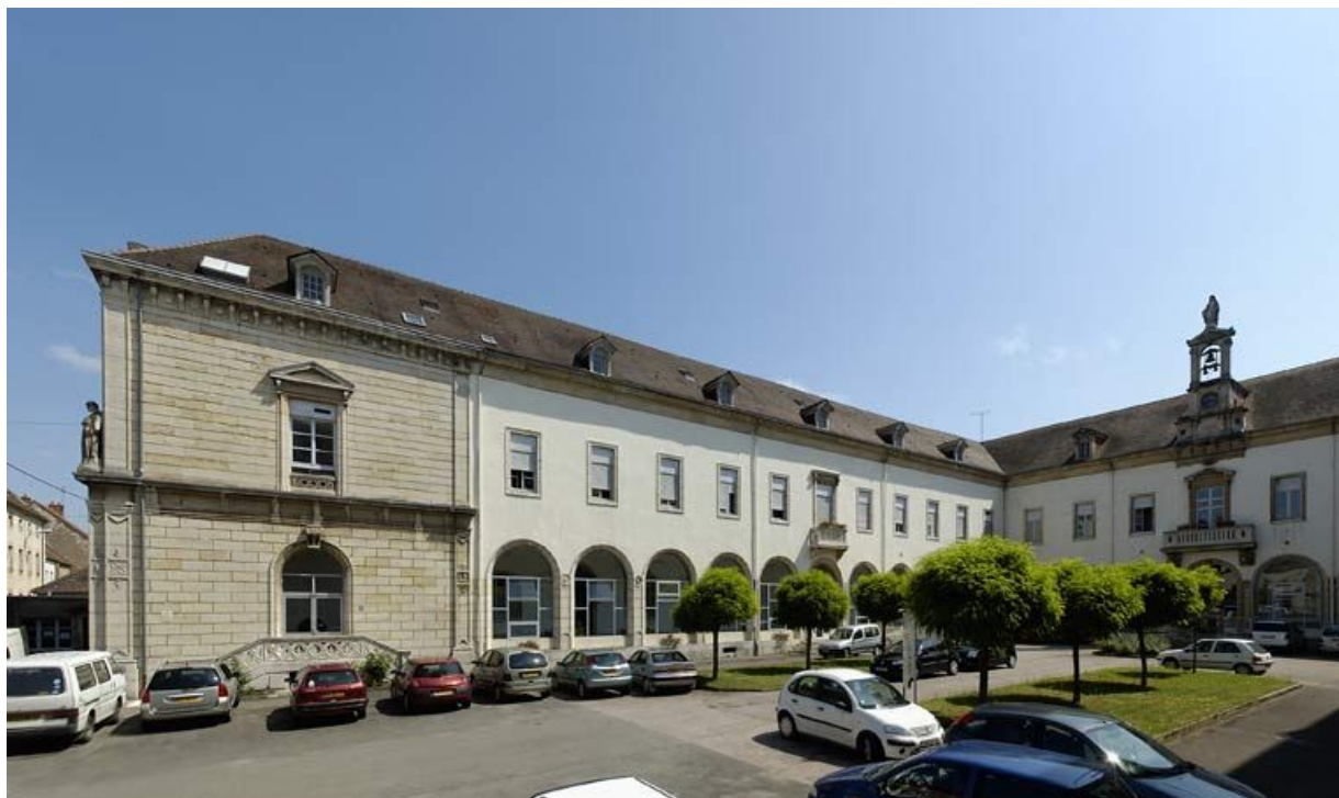
Aile gauche et corps de bâtiment central.
