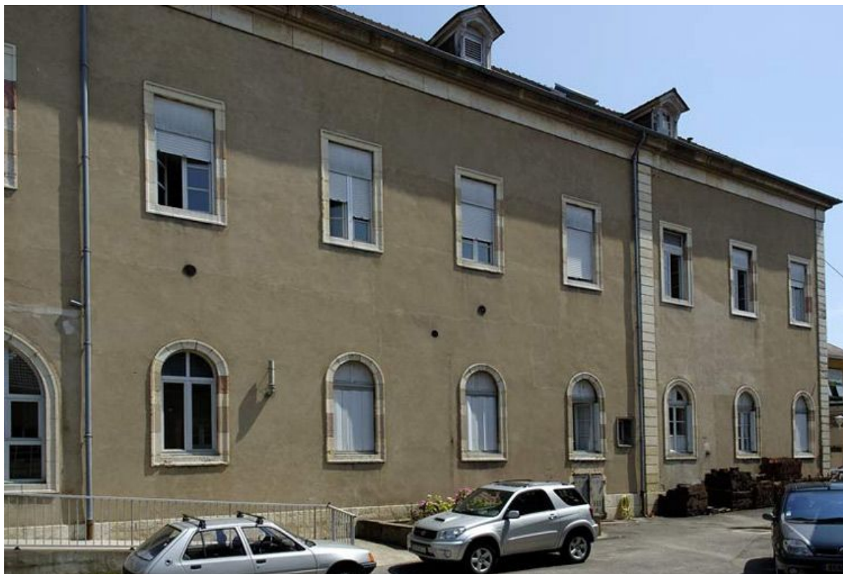
Élévation ouest de l'aile droite.
