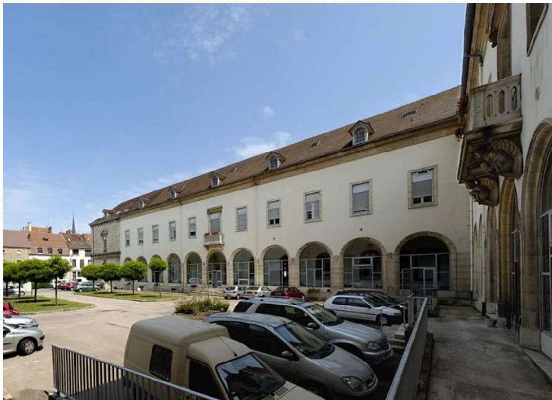
Aile gauche, élévation sur la cour d'honneur. 21, Auxonne rue Colonel-Denfert
