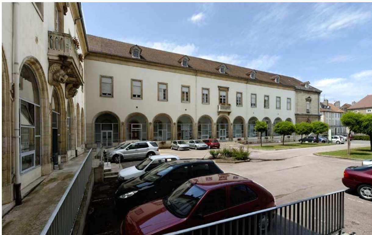
Aile droite, élévation sur la cour d'honneur. 21, Auxonne rue Colonel-Denfert
