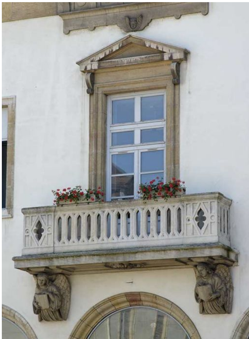
Corps de bâtiment central, détail du balcon. 21, Auxonne rue Colonel-Denfert
