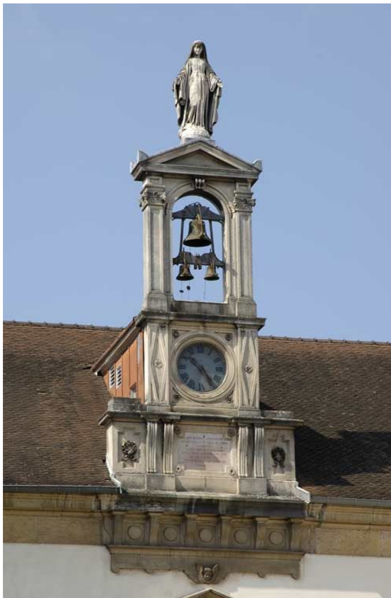
Campanile sur le corps de bâtiment central.
