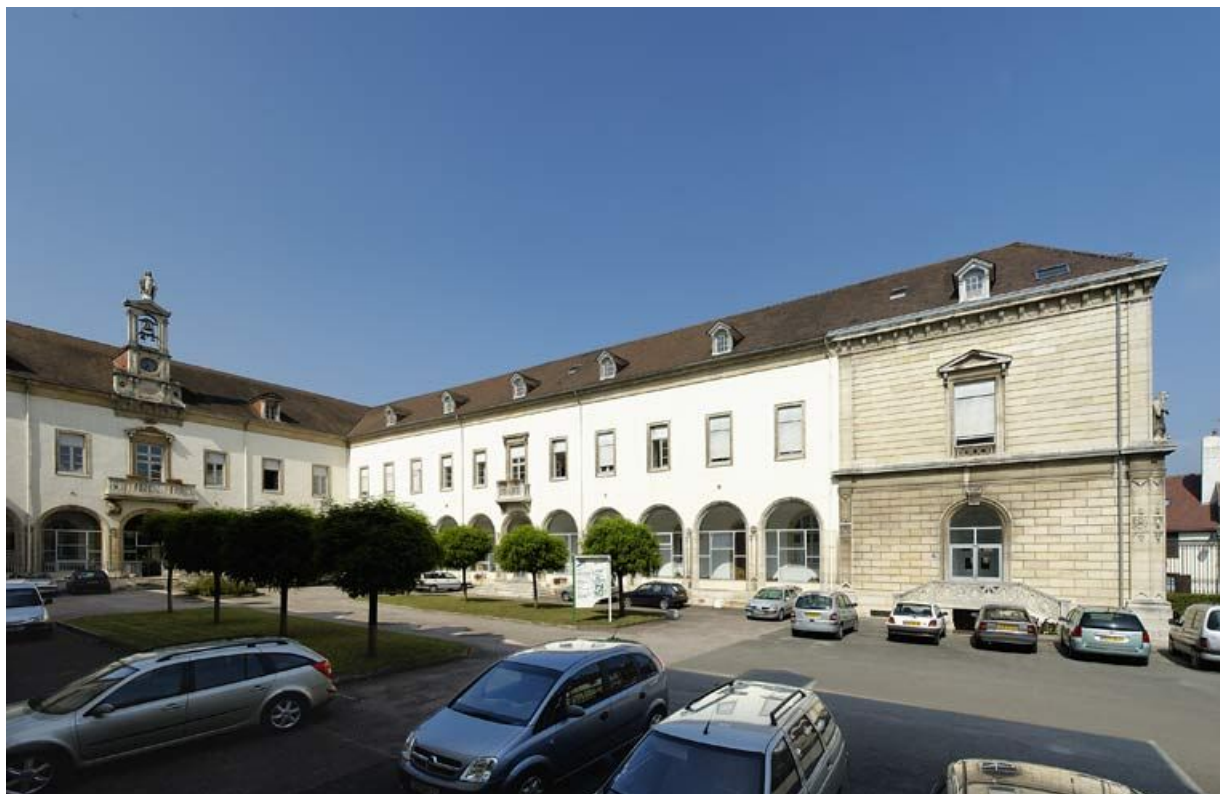
Aile droite et corps de bâtiment central.
