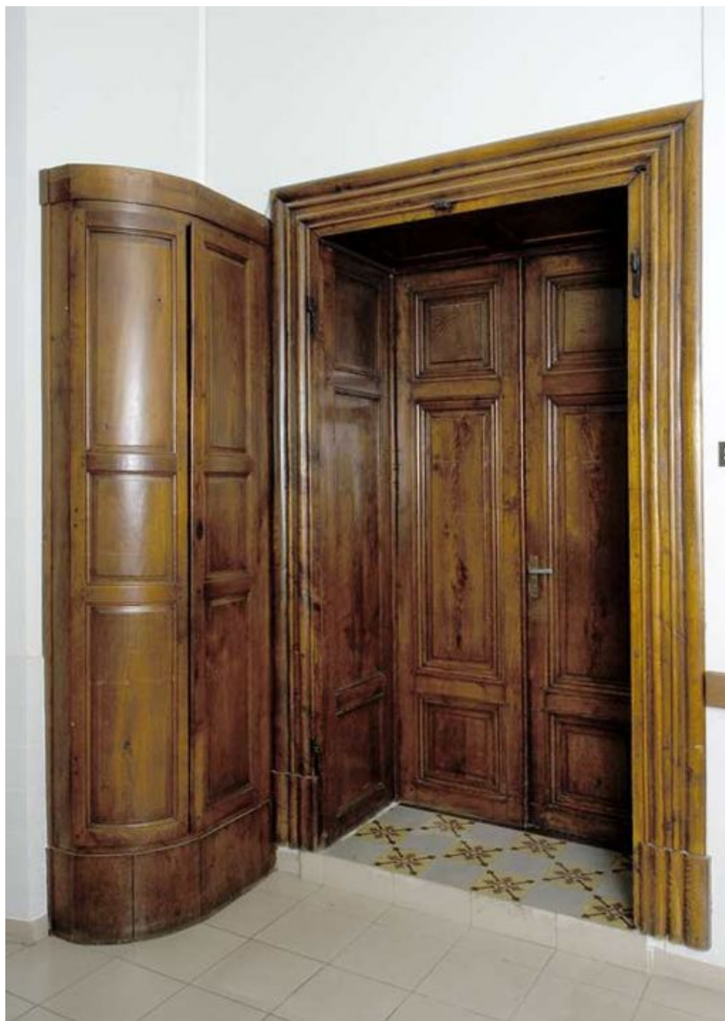
Entrée de l'ancien réfectoire des soeurs.
