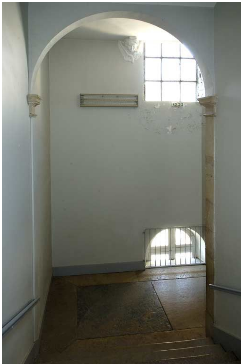
Palier de l'escalier de la galerie donnant sur la cour antérieure. 21, Auxonne rue Colonel-Denfert
