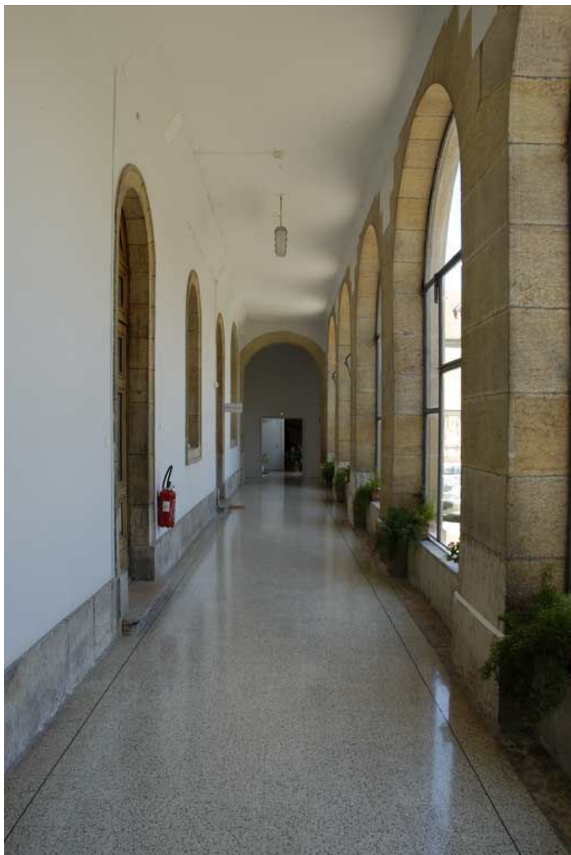
Galerie donnant sur la cour antérieure.
