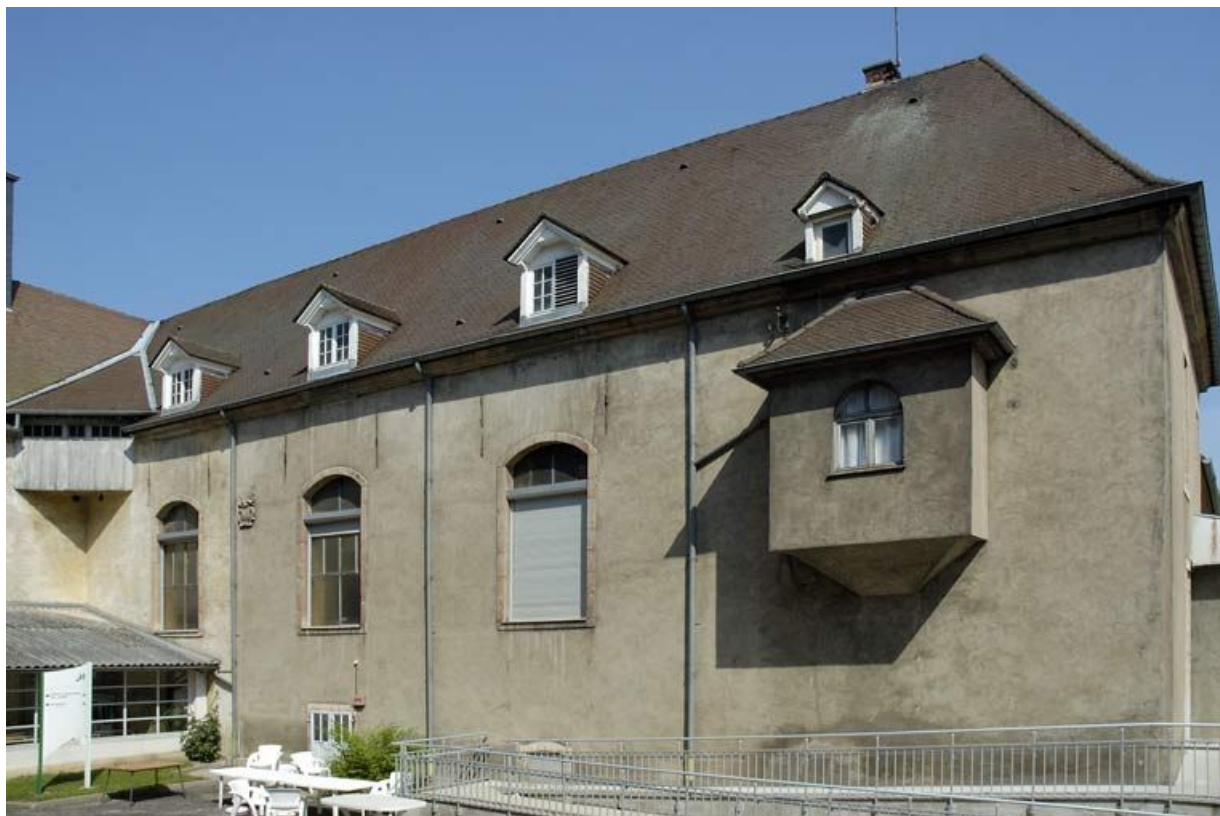
Élévation est du corps de bâtiment en retour d'équerre sur la chapelle.
