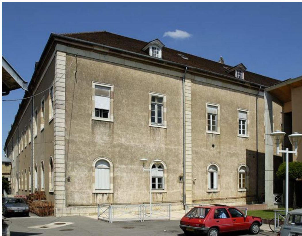
Élévation ouest de l'aile droite et sud d'une partie du corps central. 21, Auxonne rue Colonel-Denfert
