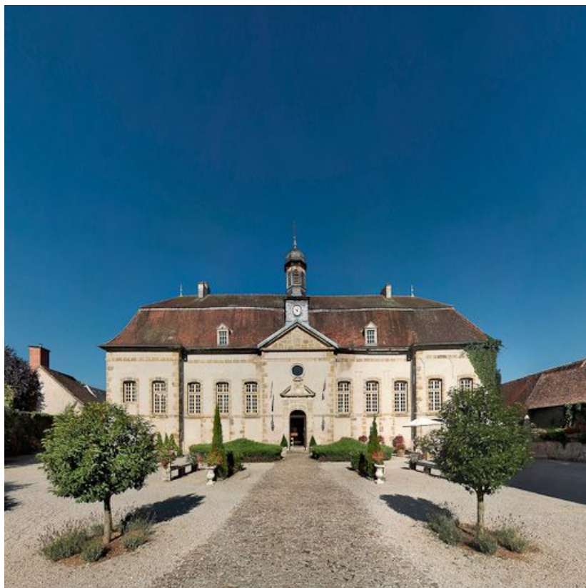
Façade antérieure du bâtiment principal.
