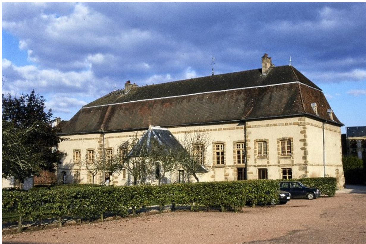
Façade postérieure en 1999.
