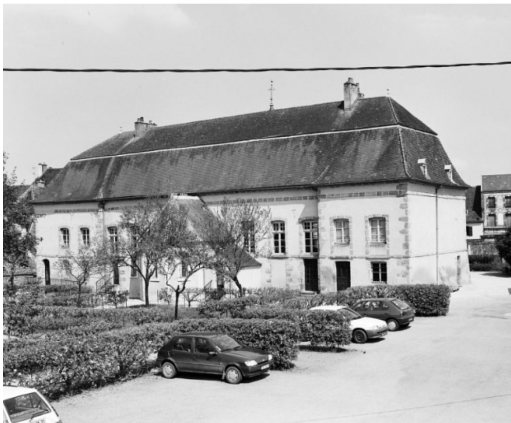
Façade postérieure en 2001.
