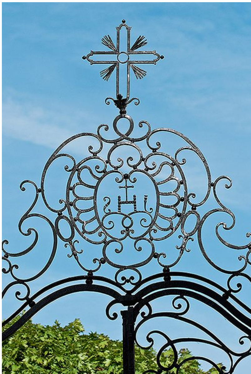
Cour d'angle sur rue : détail du couronnement du portail en fer forgé. 21, Saint-Jean-de-Losne place d' Armes
