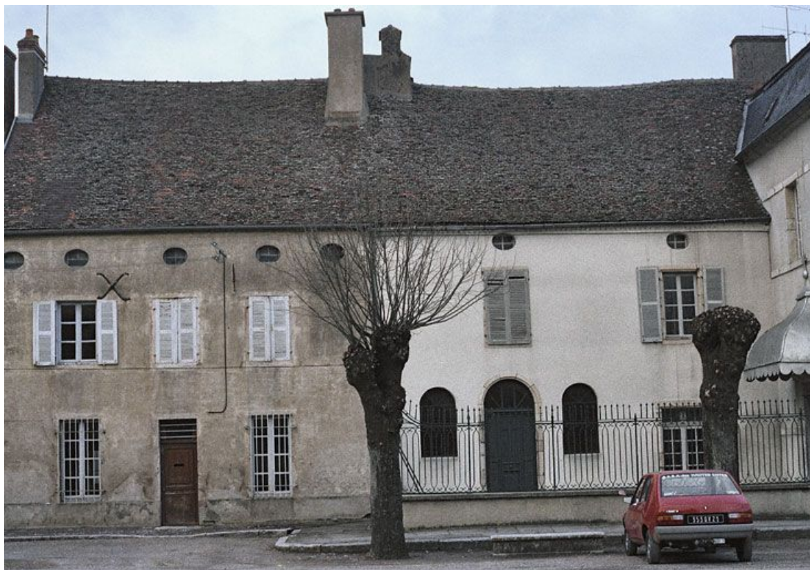
Immeuble en retrait sur la rue, avant travaux. Les ouvertures en plein-cintre de la chapelle n'existent plus. 21, Saint-Jean-de-Losne place d' Armes
