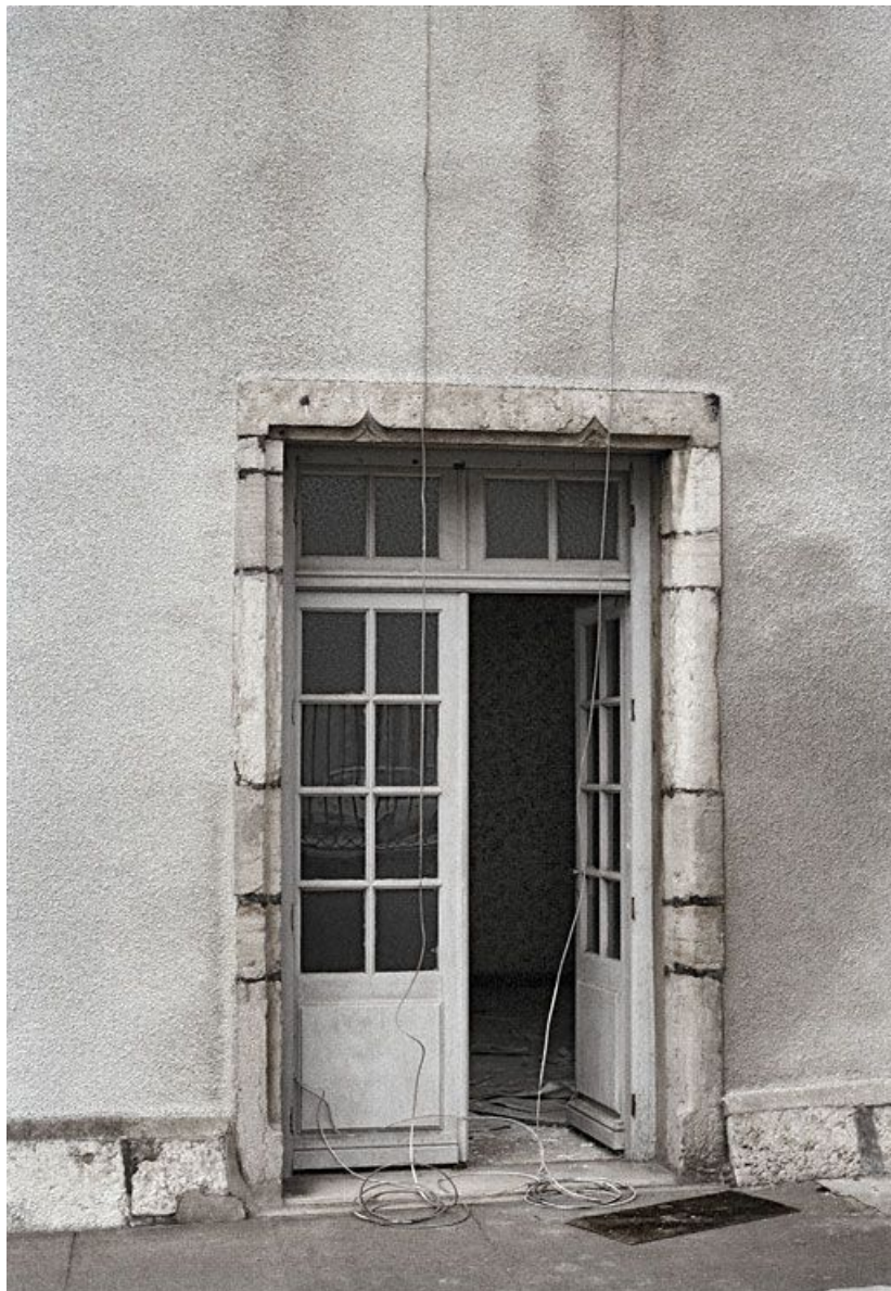
Immeuble en retrait sur la rue, avant travaux : détail de la porte à encadrement mouluré.
