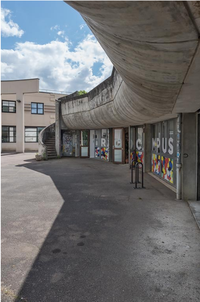
Aile semi-circulaire : toiture formant auvent côté cour.
