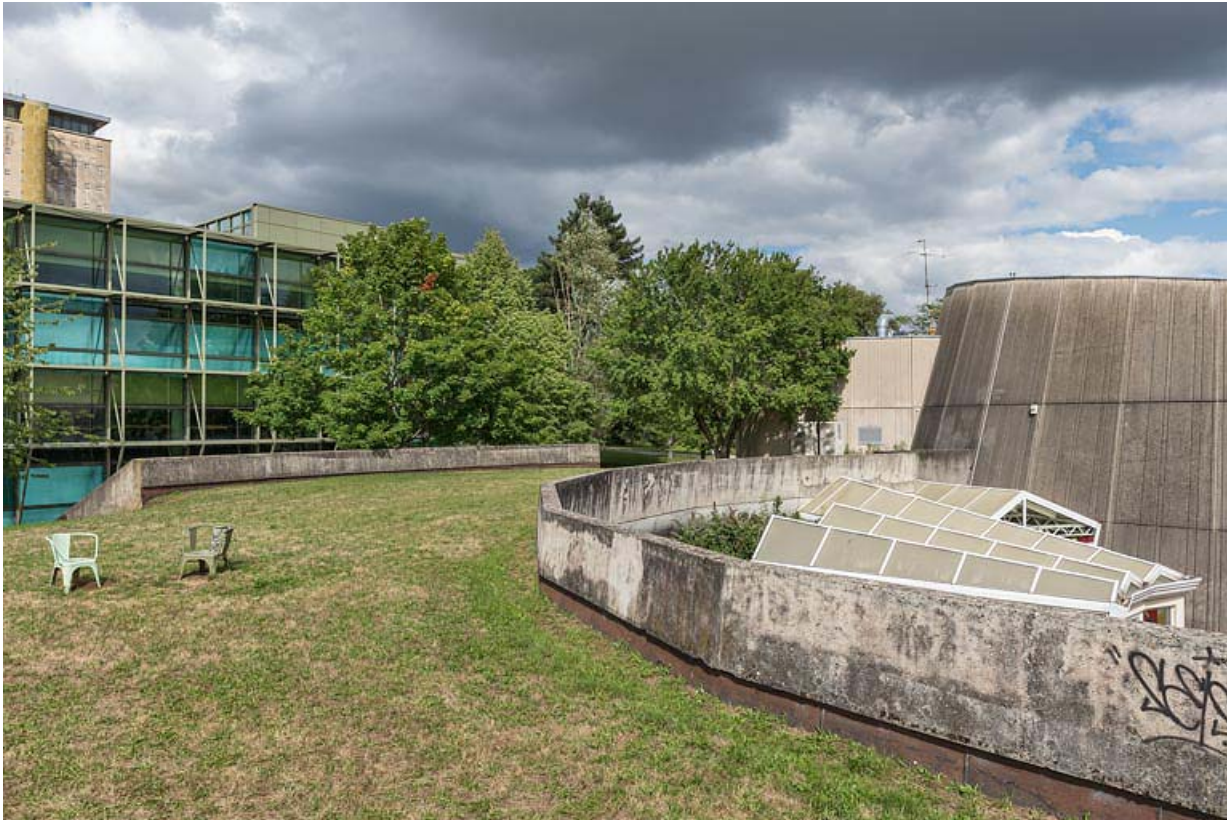
Aile semi-circulaire : toiture végétalisée.
