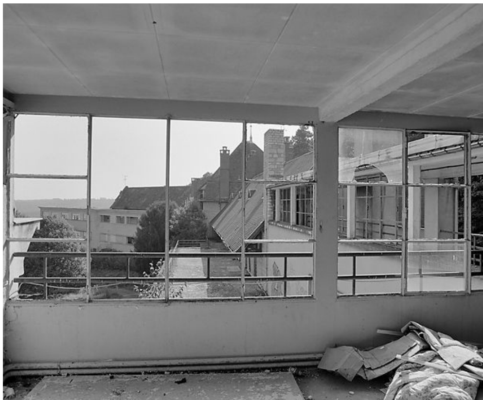
Corps central et aile est, vue prise de l'aile ouest.
