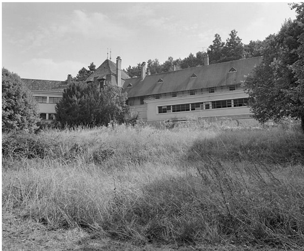
Bâtiment central, corps annexe adossé à la façade nord.
