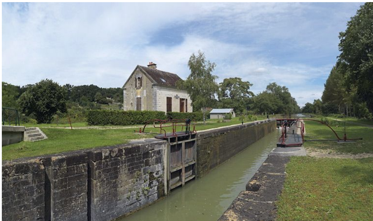
Site de l'écluse 109 du versant Yonne, dite de la Maladrerie, à Saint-Florentin : vue d'aval.
