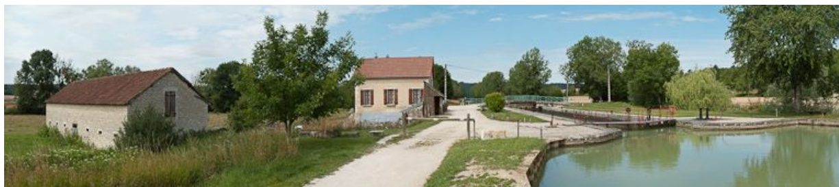
Site de l'écluse 94 du versant Yonne, dite d'Arcot, à Tonnerre : vue d'ensemble.
