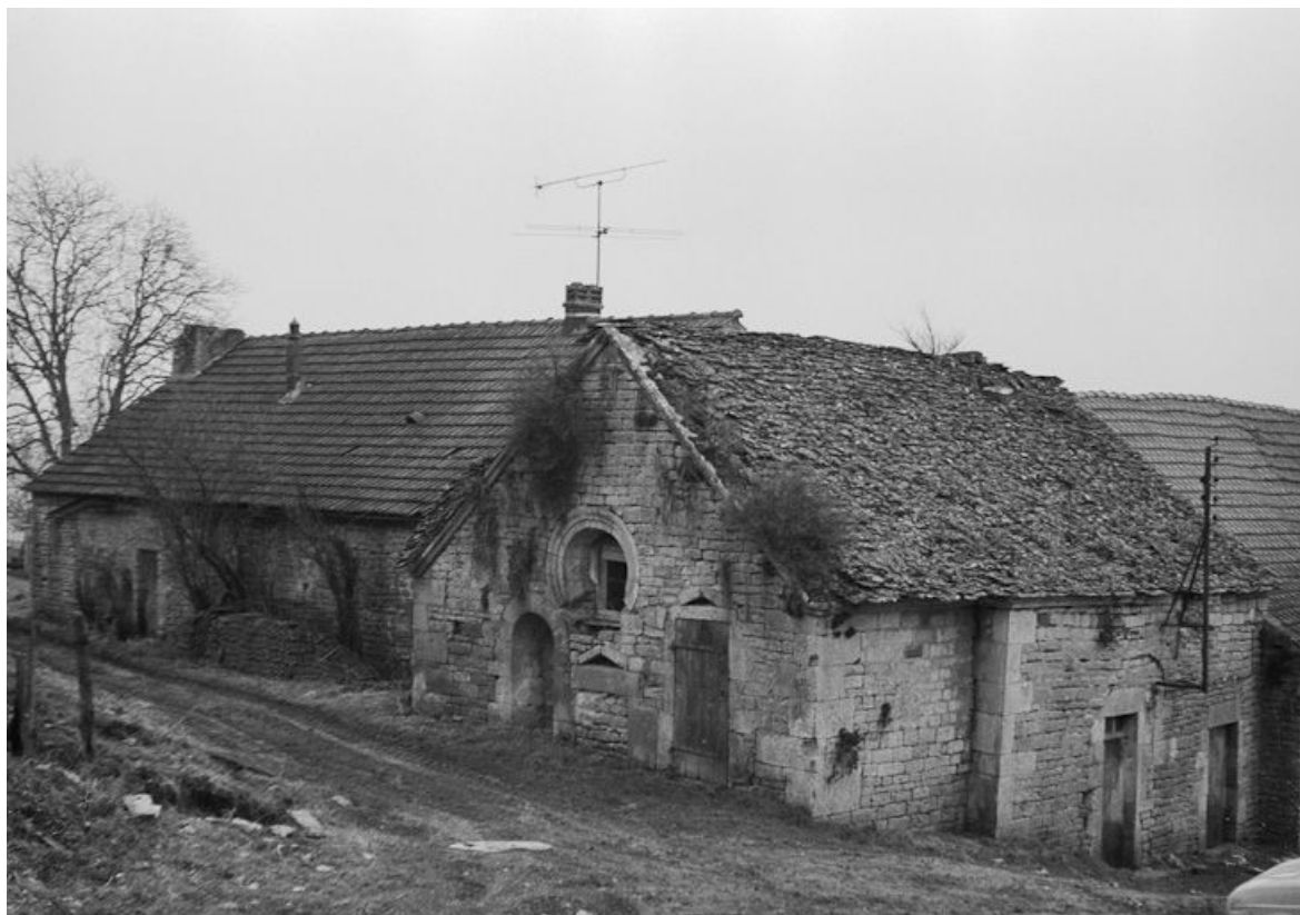
Vue d'ensemble de la chapelle et du bâtiment qui la flanque.
