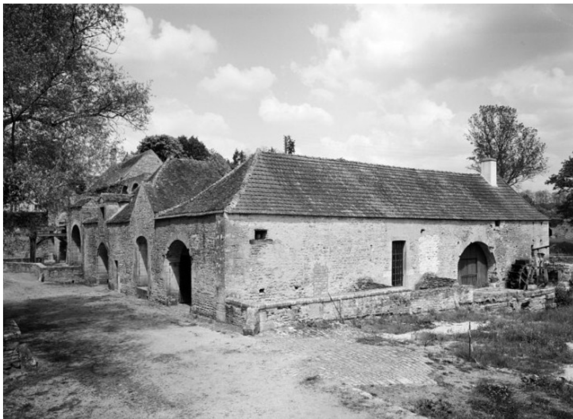
Bâtiment de la fenderie, vue prise du sud-est.
