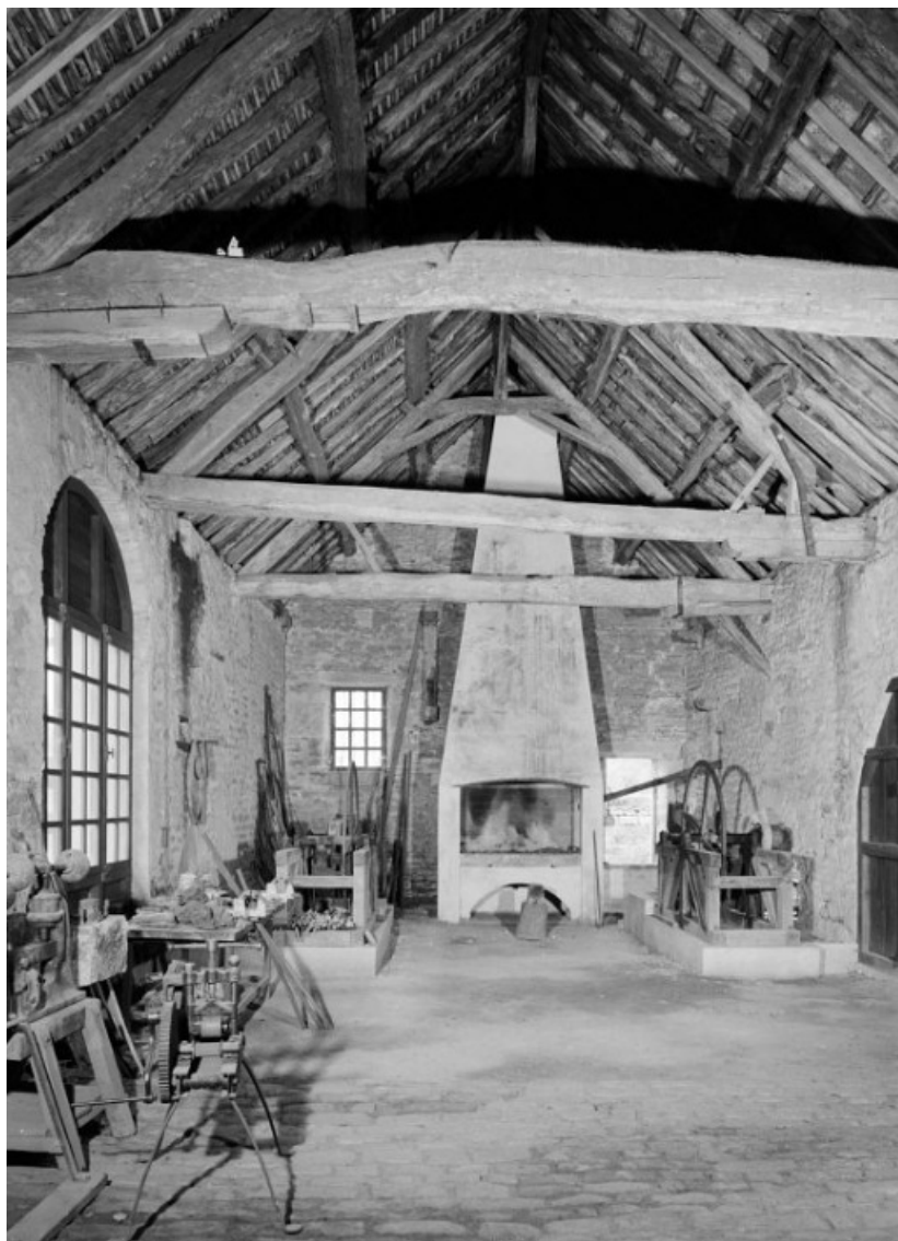
Bâtiment de la fenderie, vue intérieure prise du sud.
