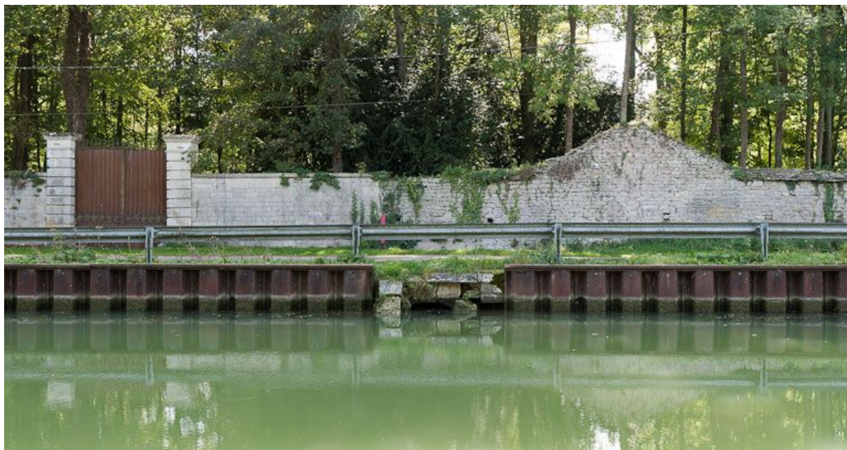
Vue de la clôture du domaine donnant sur le canal.
