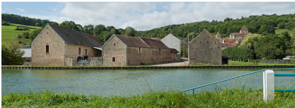
Au premier plan : des corps de ferme en bordure du canal, à l'arrière-plan : le château de Courcelles-lès-Montbard. 21, Courcelles-lès-Montbard, lieudit : bief 61 du versant Yonne
