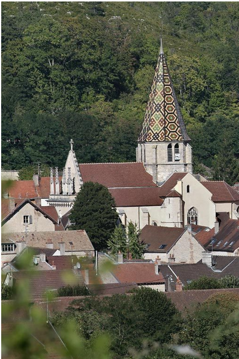
Le clocher de l'église Saint-Baudèle de Plombières-lès-Dijon, vu du canal. 21, Plombières-lès-Dijon, lieudit : bief 50 du versant Saône
