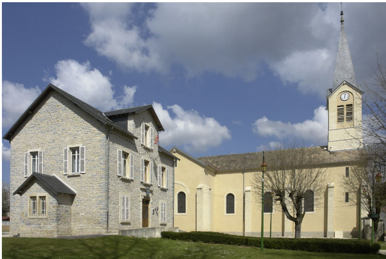
Élévation latérale gauche, vue d'ensemble avec au premier plan, l'ancien presbytère actuellement mairie. 21, Velars-sur-Ouche, lieudit : bief 45 du versant Saône
