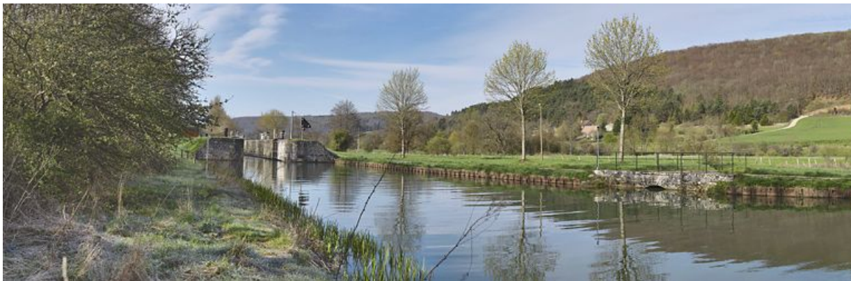
Arrivée de la rigole au canal rive gauche. En arrière-plan, le site d'écluse 28. 21, Saint-Victor-sur-Ouche, lieudit : bief 28 du versant Saône
