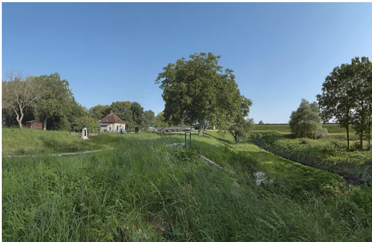
Vue d'ensemble du système hydraulique composé d'un déversoir de fond-aqueduc et d'une rigole de fuite. 21, Brazey-en-Plaine, lieudit : bief 75 du versant Saône
