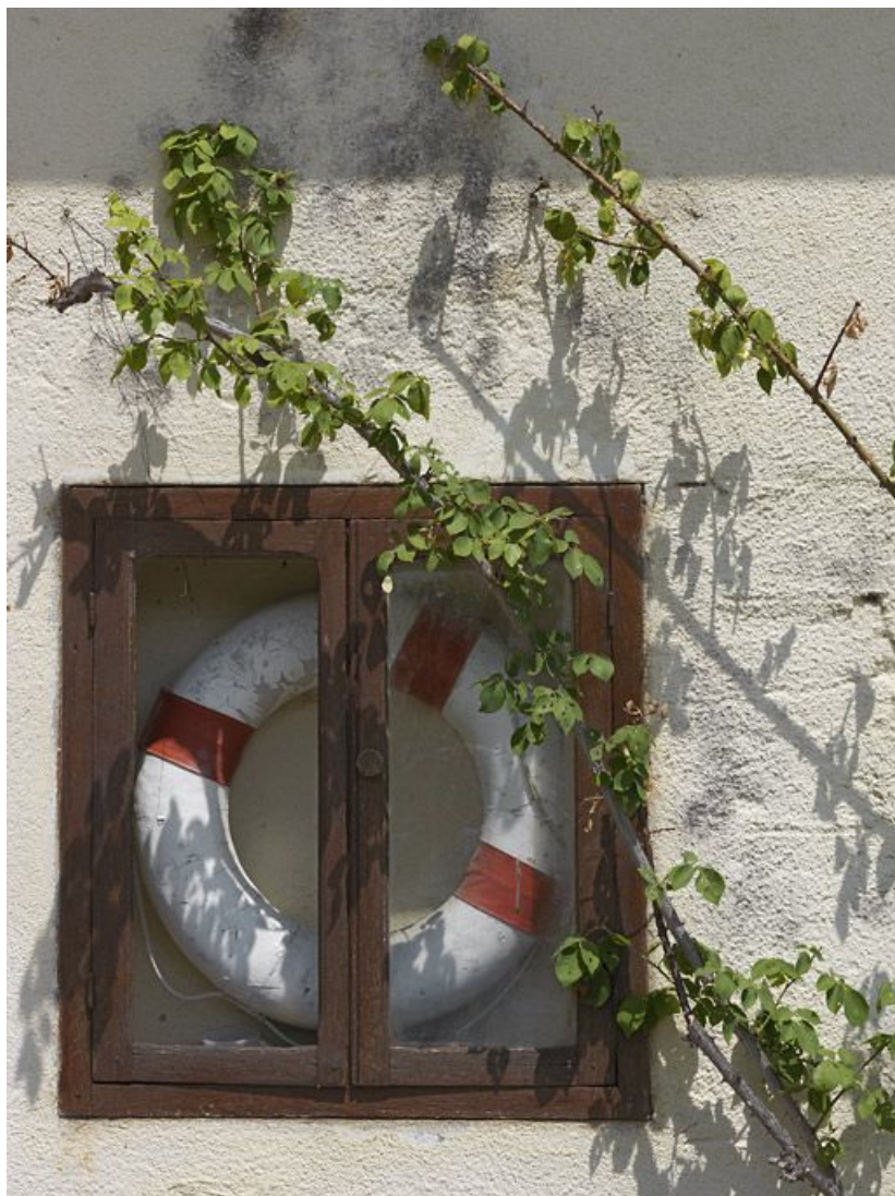
Détail de la bouée sur la façade de la maison éclusière.
