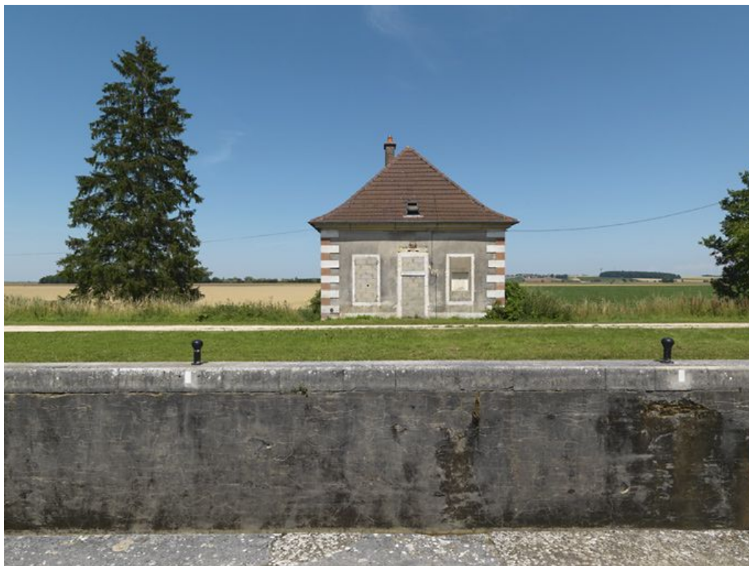
Maison éclusière : vue de face.
