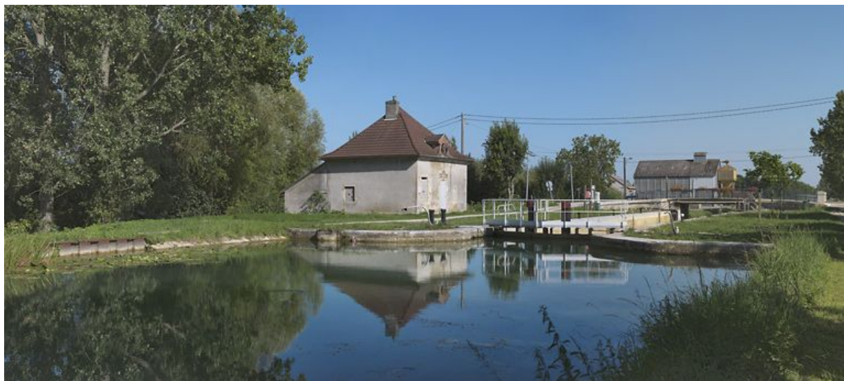
Site de l'écluse 67 du versant Saône, dite de Thorey, à Thorey-en-Plaine : vue d'amont.
