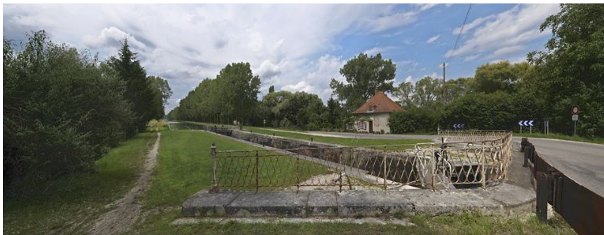
Vue d'ensemble du site, pris d'aval, avec le pont en premier plan.
