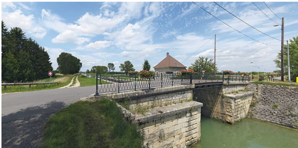
Pont pris d'aval. Le rehaussement est visible à la différence de maçonnerie des piles.
