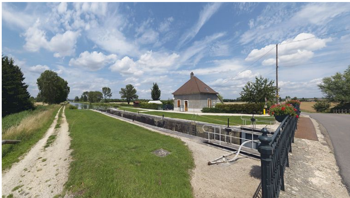
Site d'écluse pris d'aval. Le dessin du garde-corps du pont sur écluse est bien visible.
